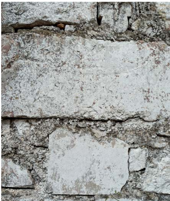
Detalles del muro construido con los restos de la portada, situado en el patio
