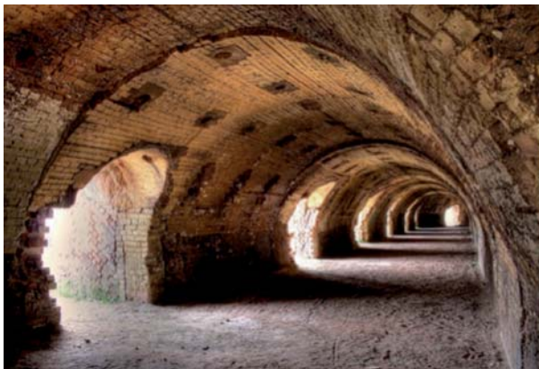
Figuras 13 y 14: Hornos Continuos tipo Hoffmann - Izquierda zona inferior y de cocción - Derecha zona superior para alimentación y supervisado. Fuente: Atlas-archi-construcciones. Créditos atlas.carlosquintas.com
