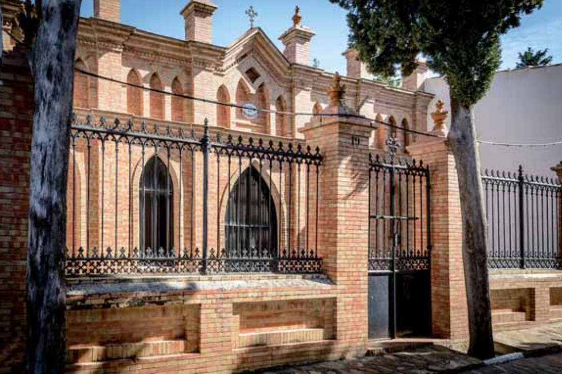
Panteón capilla construido en ladrillo y decorado con motivos historicistas que nos recuerdan el estilo "gótico-mudéjar".
