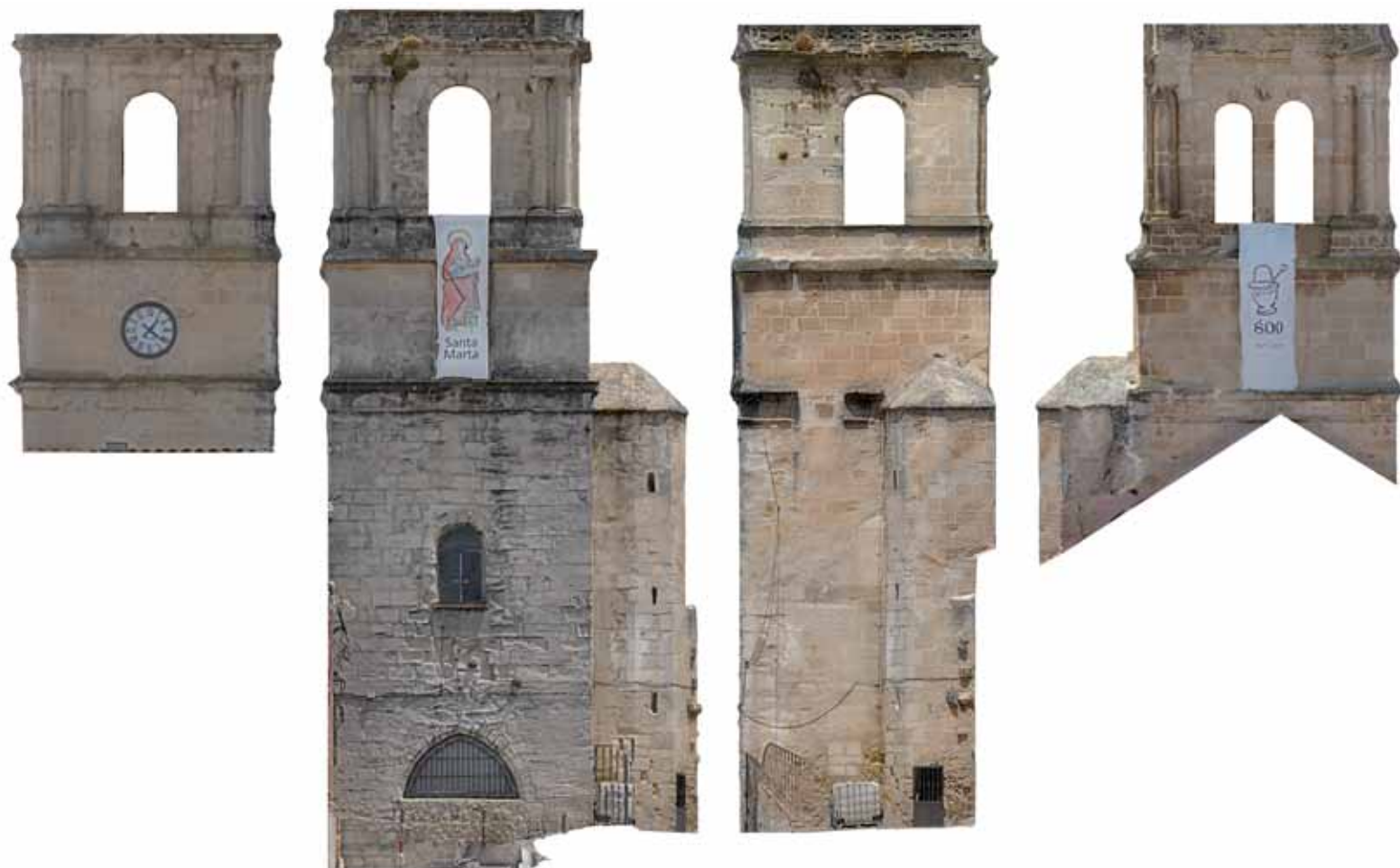
Ortofotografías de los cuatro lienzos de la torre.
