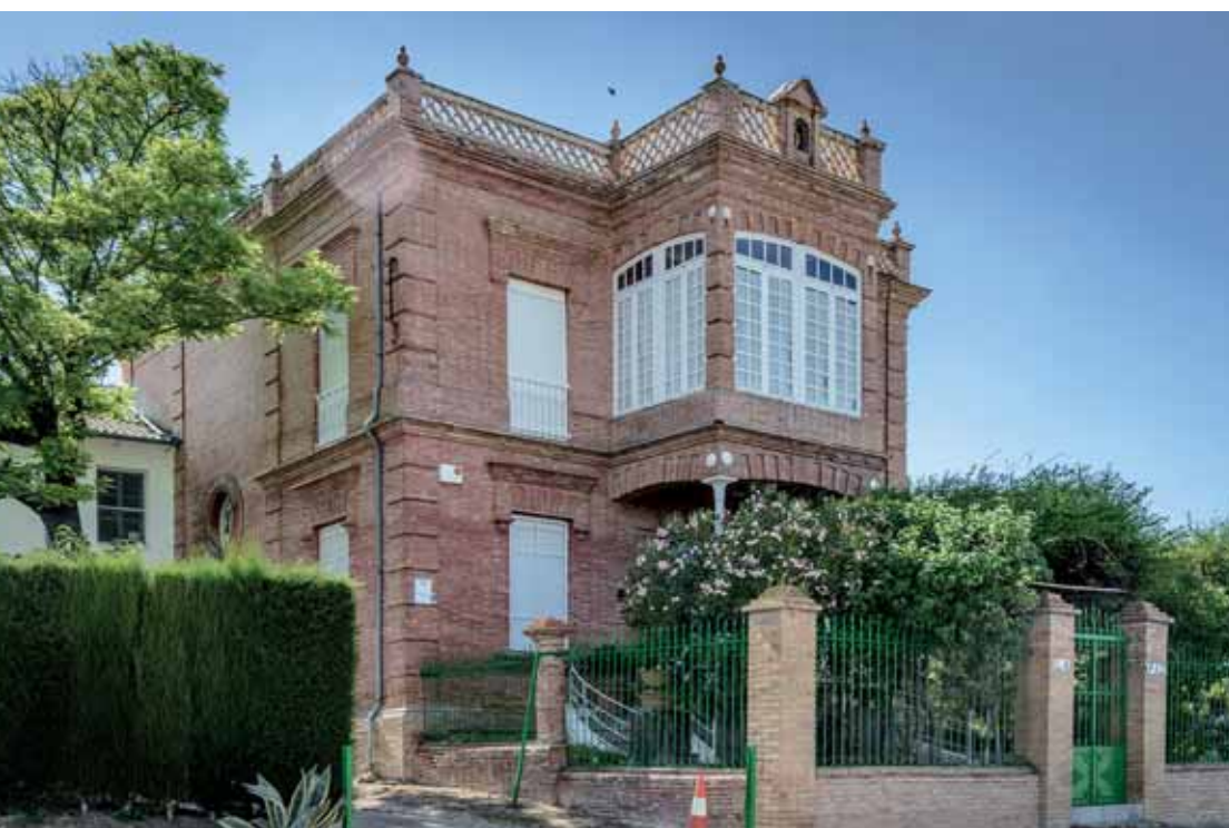
Casa situada en la carretera a Fuensanta, donde el ladrillo ofrece todas sus posibilidades constructivas y decorativas.
