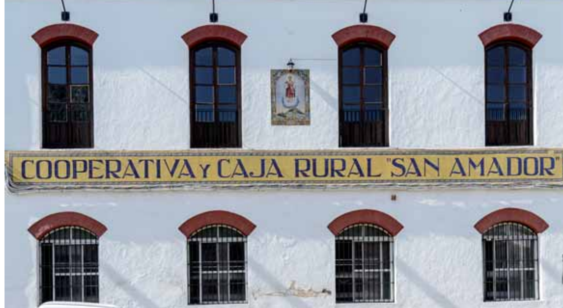
Detalle de la fachada de la Cooperativa San Amador, en la calle Príncipe Felipe, nº 20.
