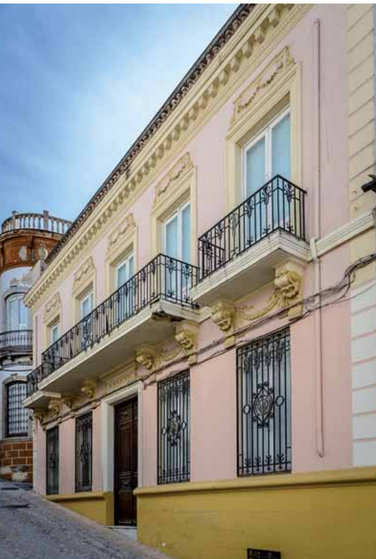
Fachada de gran riqueza ornamental y rejería modernista en el Albollón, nº 29.
