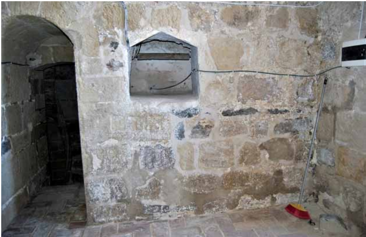
Paramento de piedra ubicado en la estancia interior de la torre.
