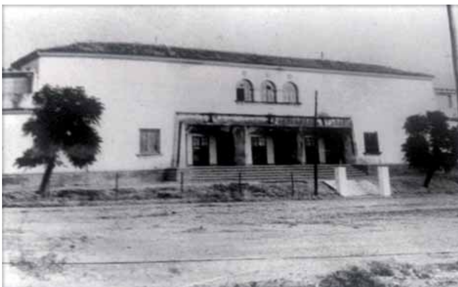
Fachada del Albergue San Fernando.
