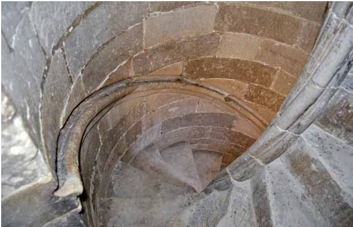
Escalera de piedra en la que se ha eliminado la pintura de los muros.
