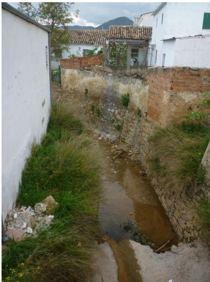
Ilustración 11. Aspecto del arroyo de las Máquinas encajado entre dos edificios. Notar que la profundidad es muy elevada, lo que evita afecciones a las viviendas.
