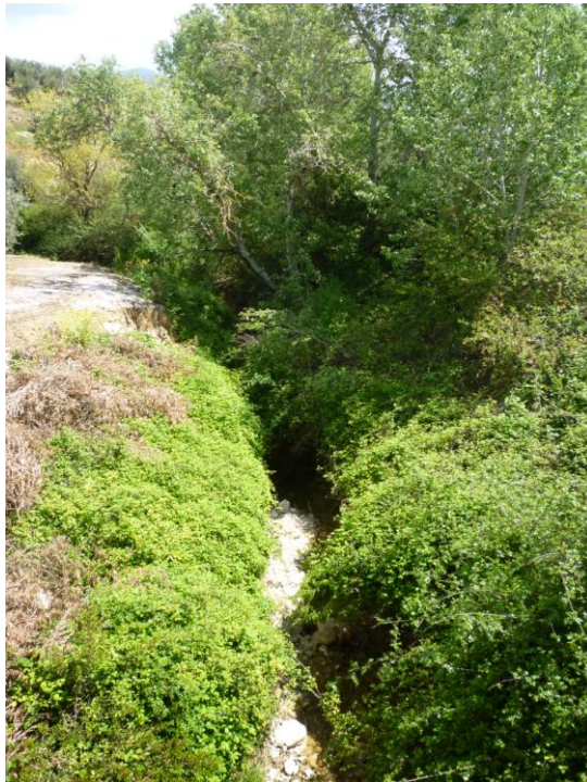
Ilustración 5.- Vista del arroyo Rioliche desde la segunda estructura.
