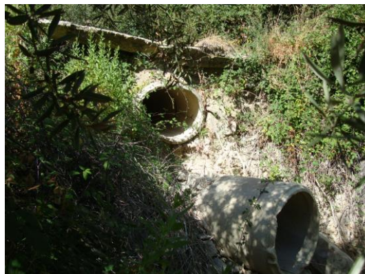
Tubería de hormigón de D=800 junto a badén superior. I=3%
