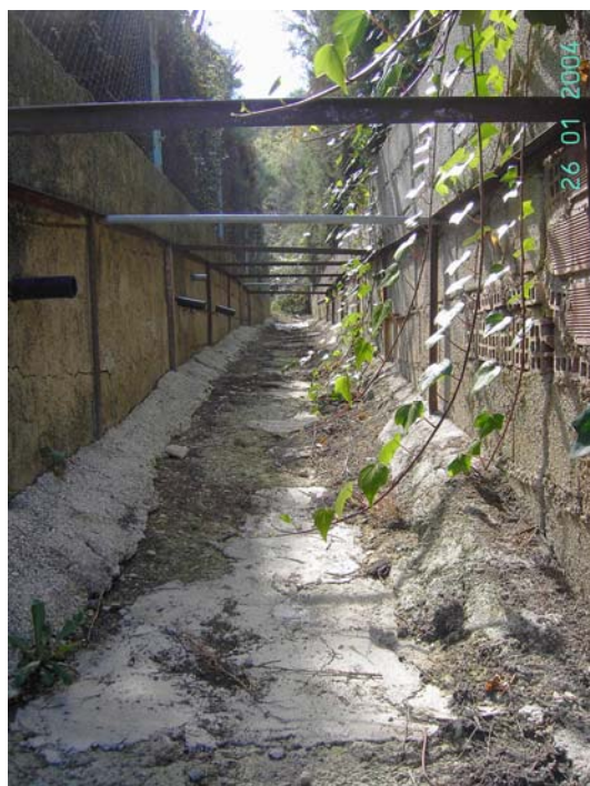
Ilustración 2. Vista del tramo en cajón.
