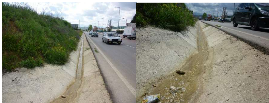
Ilustración 14.- Aspecto actual de la cuneta. Se encuentra en buen estado y dispone de pendiente suficiente (2%)
