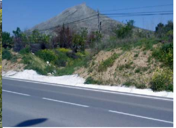
Ilustración 5. Desembocadura a la cuneta de la carretera JA-3305
