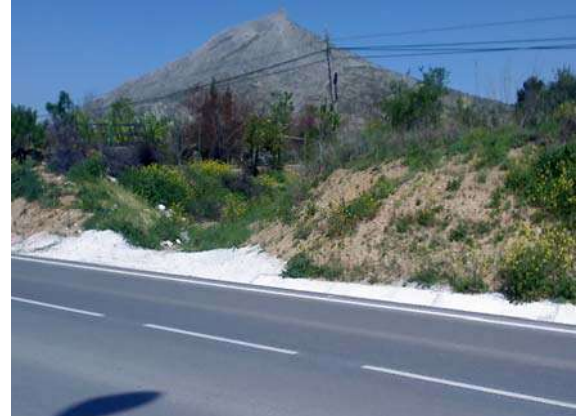
Ilustración 6. Desembocadura a la cuneta de la carretera JA-3305
