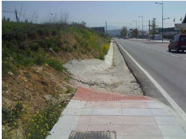
Ilustración 18. Desembocadura del Arroyo Larija a la cuneta de la JA-3305
