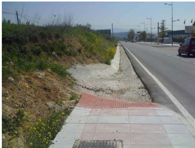
Ilustración 13. Desembocadura del Arroyo Larija a la cuneta de la JA-3305
