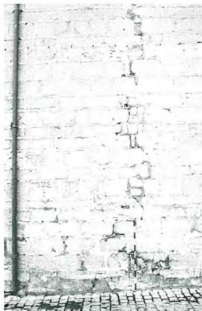
Grieta exterior de la Capilla.
