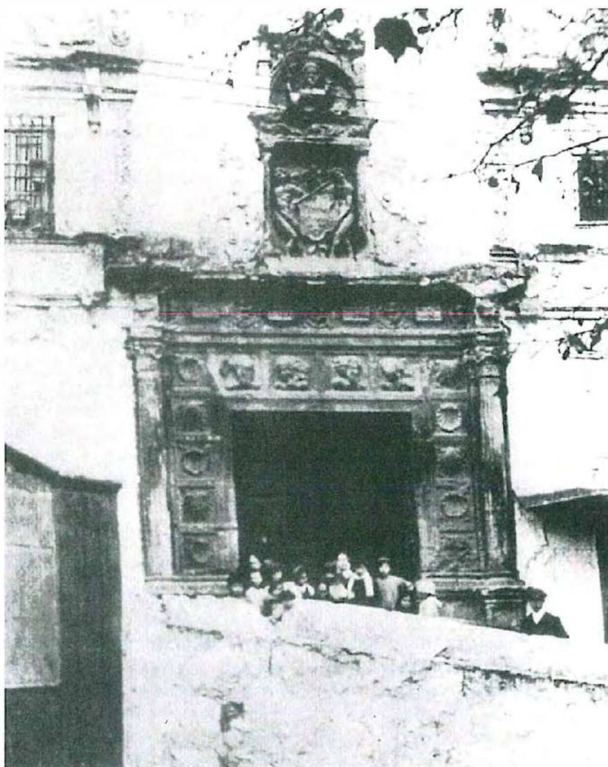
Fachada del Convento de Santa Clara de Martos, fundado en la casa de la familia Ortega.
