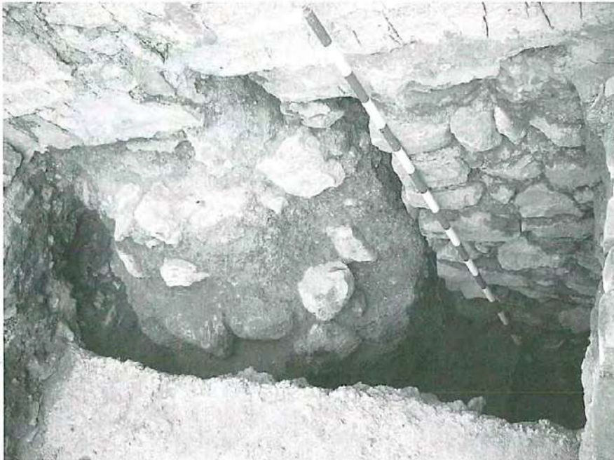
Arreglo de la grieta al exterior de la Capilla.
