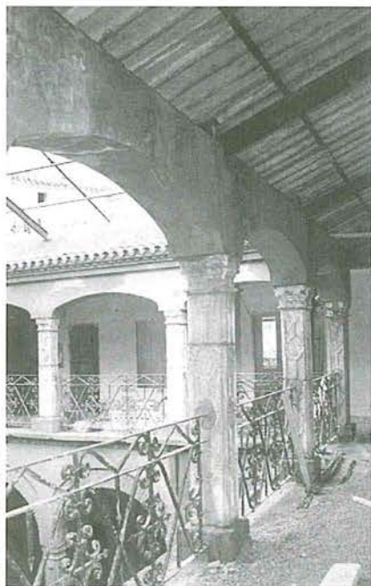
Galería superior del patio
