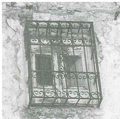
Ventana con reja de cajón abierta en el muro
