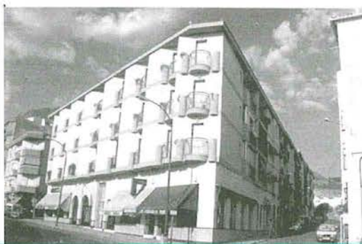
Edificio La Rambla - Martos
