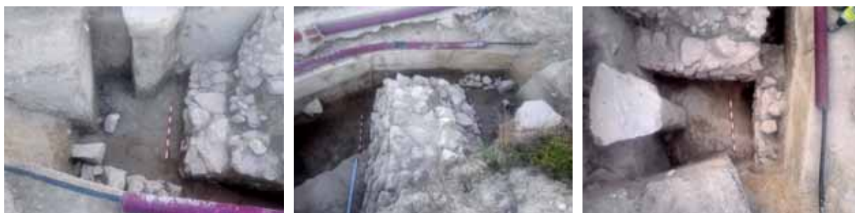
Fig. 10. Zona interior. Imágenes de la relación contextual entre las cimentaciones en piedra caliza del muro de fortificación ataluzado y de la base de los muros inferiores, a doble cara, más antiguos.
