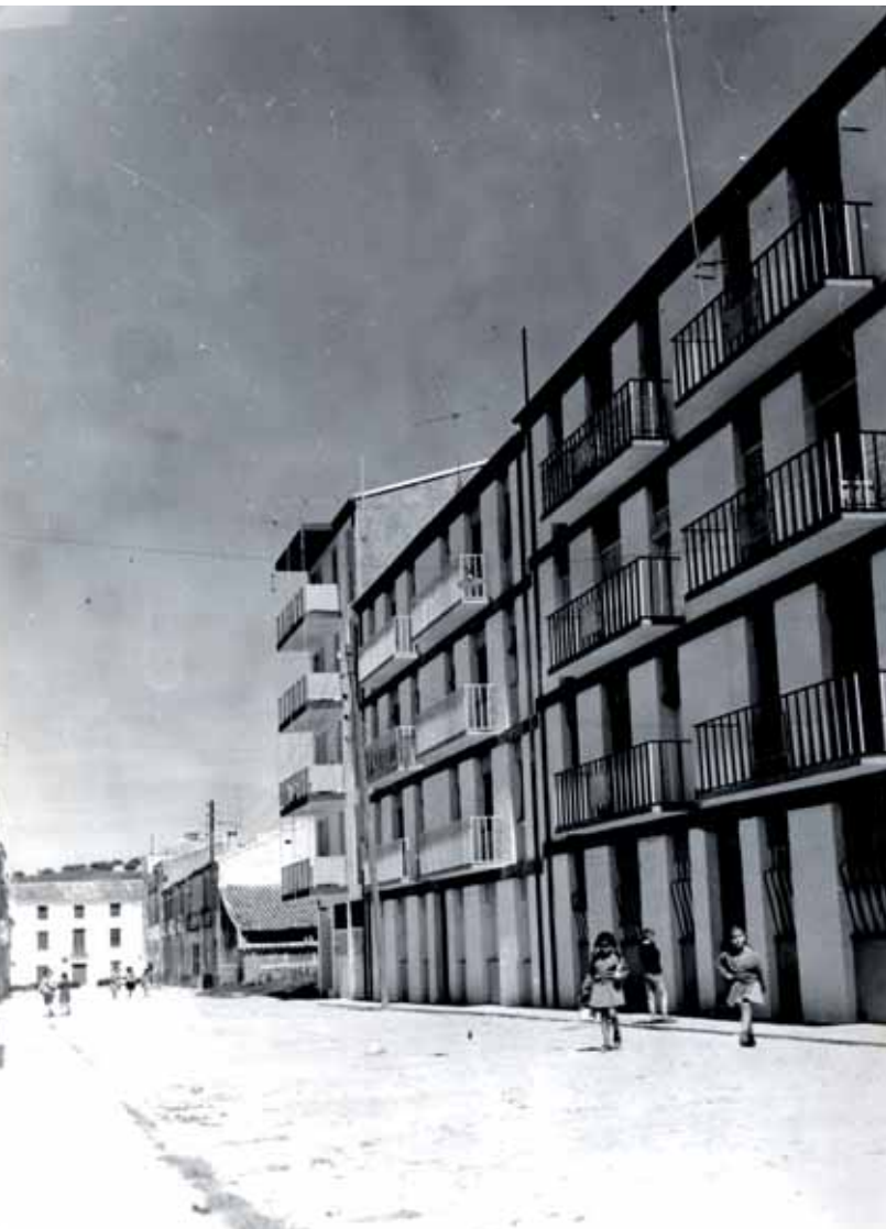
Calle Manuel Caballero, llamada así por Manuel Caballero, vecino de Martos, que compró terrenos y edificó una promoción de casas en los años 40. Son casas de dos plantas, de las que hoy quedan algunas. Se ven al comienzo de la calle, en la acera de la derecha. Al fondo observamos una casa de la calle del Monte, actual calle del Oro Verde. AHMM, foto que acompaña al expediente del Plan de Ensanche de Martos de 1945.
