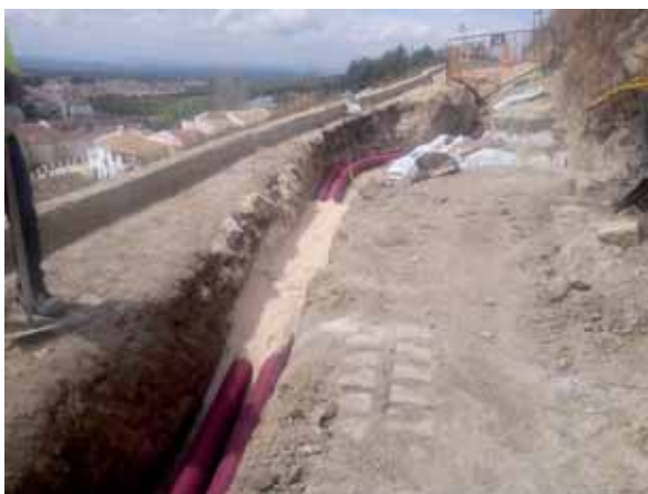
Fig. 8. Imágenes del resultado de la solución propuesta para el paso de la nueva acometida eléctrica sin afección a los restos arqueológicos.
