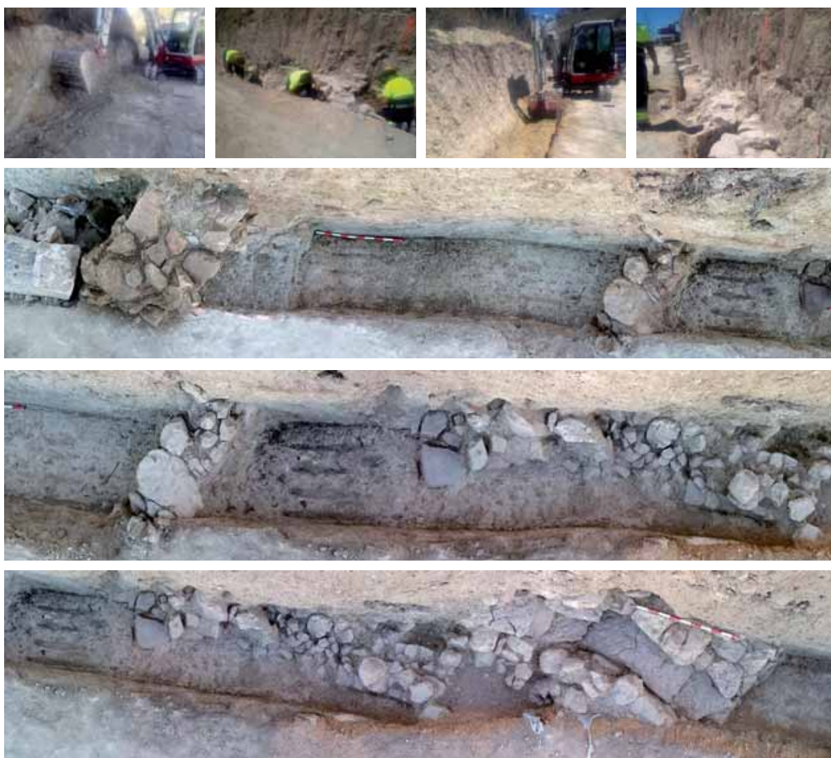
Fig. 14. Pceso del recorte de la zona superior del talud y apertura de la zanja de cimentación de la escollera con medios mecánicos y manuales.
