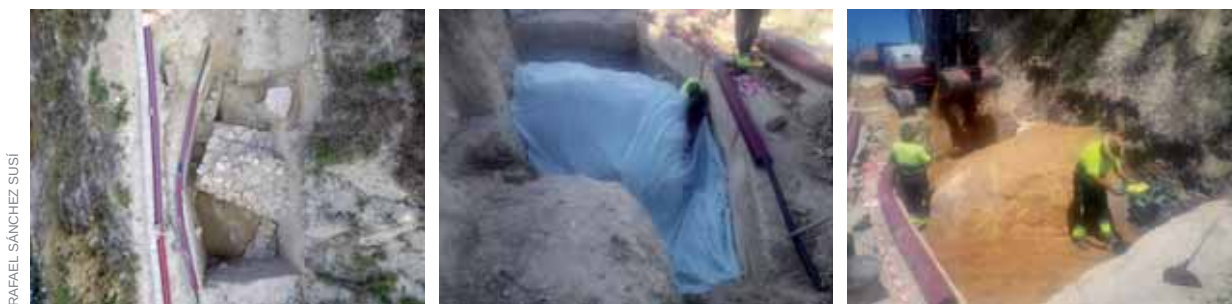
Fig. 13. Zona Interior. Imágenes del final de la excavación arqueológica del sondeo estratigráfico y de su protección y conservación in situ .
