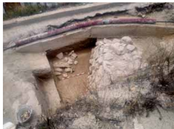
Fig. 8. Imágenes del resultado de la solución propuesta para el paso de la nueva acometida eléctrica sin afección a los restos arqueológicos.
