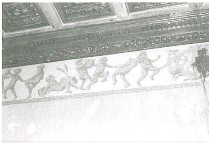
Biblioteca-despacho. Artesonado en escayola, pintado imitando madera y franja de querubines
