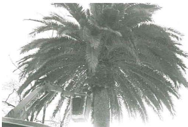
Trabajos de mantenimiento - Taller de Jardinería en Casa Regionalista
