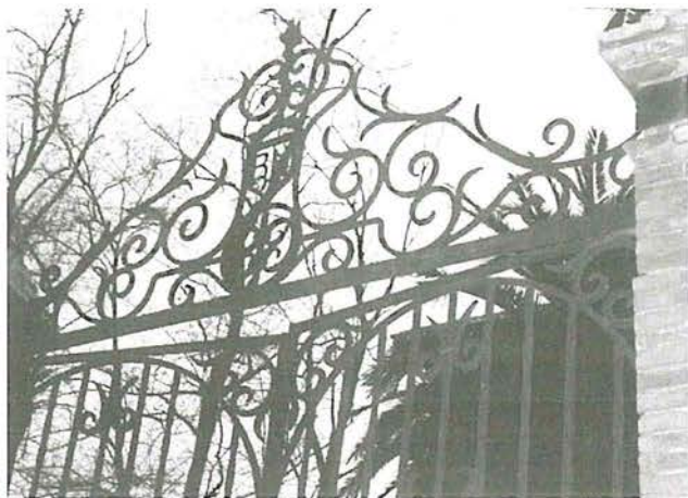
Puerta de entrada al recinto, realizada en hierro forjado con las iniciales del dueño R. M.
