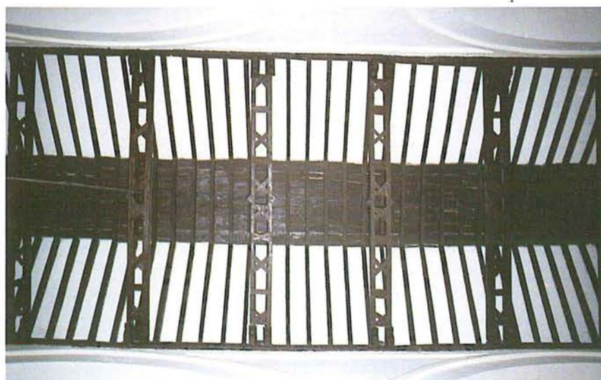
Cubierta de la nave central
