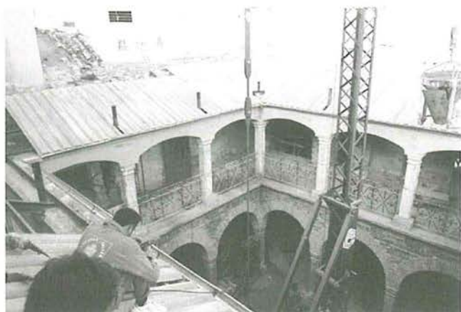
Colocación de cubiertas en el Hospital e Iglesia de San Juan de Dios
