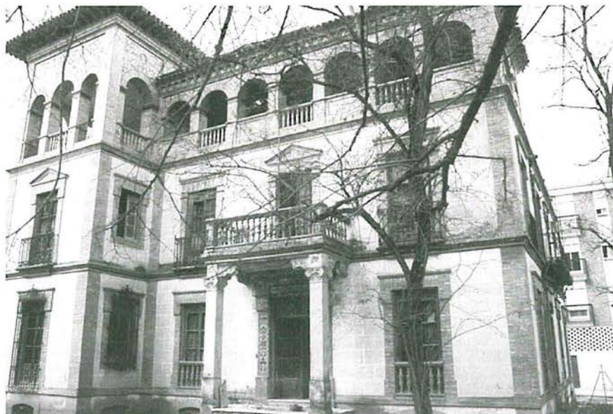
Fachada principal y torreón. Vista general
