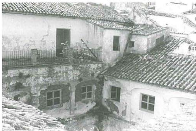
Estado inicial del patio del Hospital de San Juan de Dios
