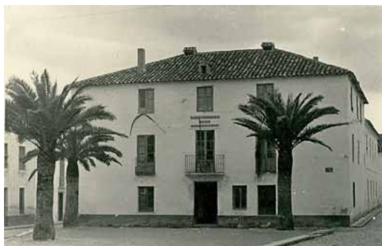
Cuartel de Villadompardo, 1957.
