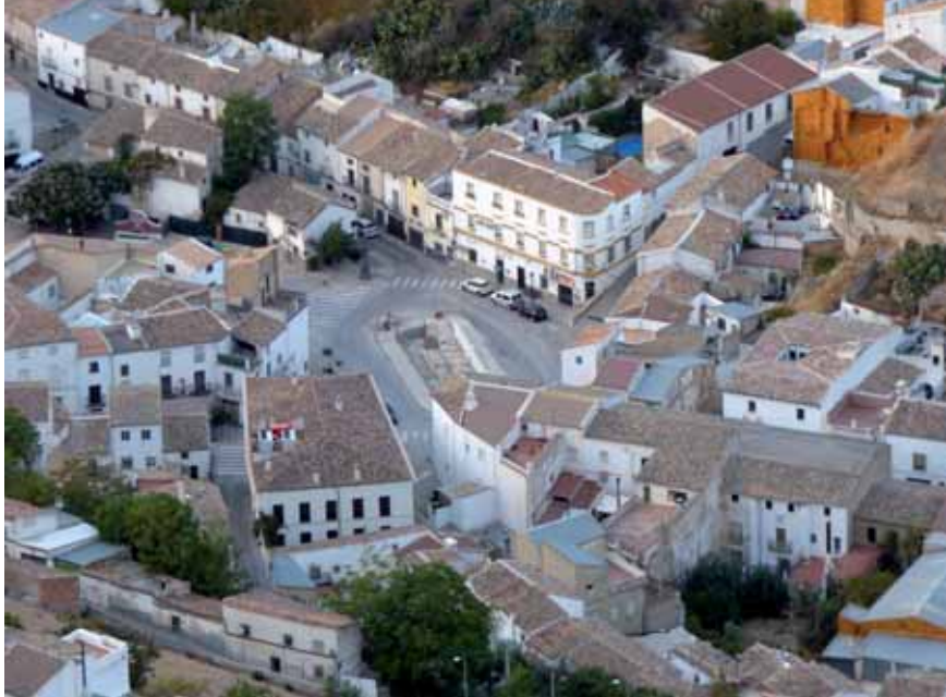
Perspectiva de la plaza de la Fuente de la Villa desde La Peña durante las obras.
