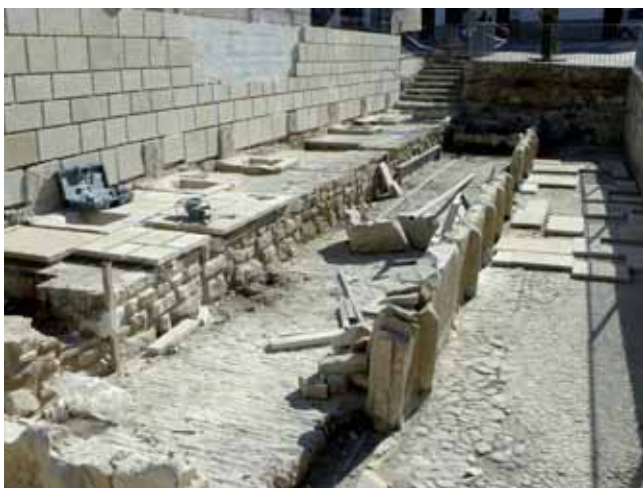
Martos. Fuente de la Villa. Obras de recuperación. Año 2017.
