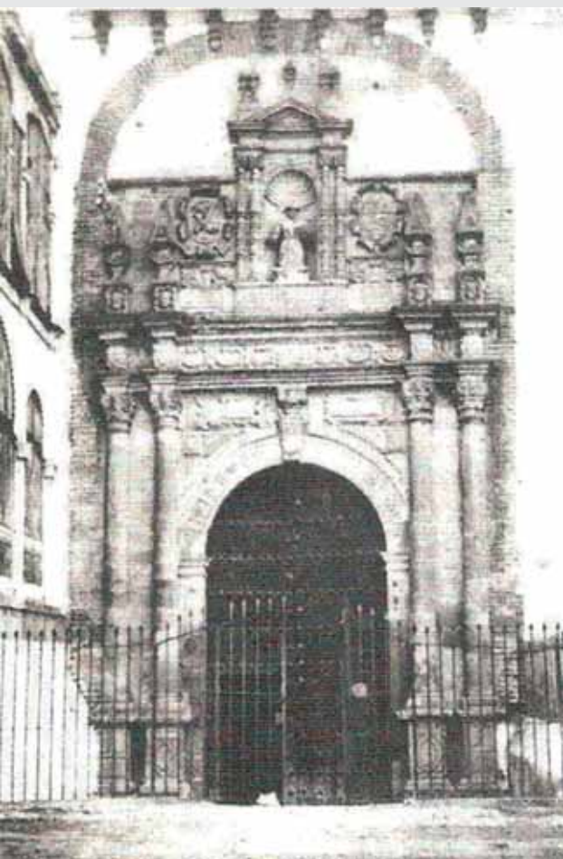
25. Portada de la antigua iglesia de S. Francisco; al lado se aprecian las ventanas del café “Alhambra”.
