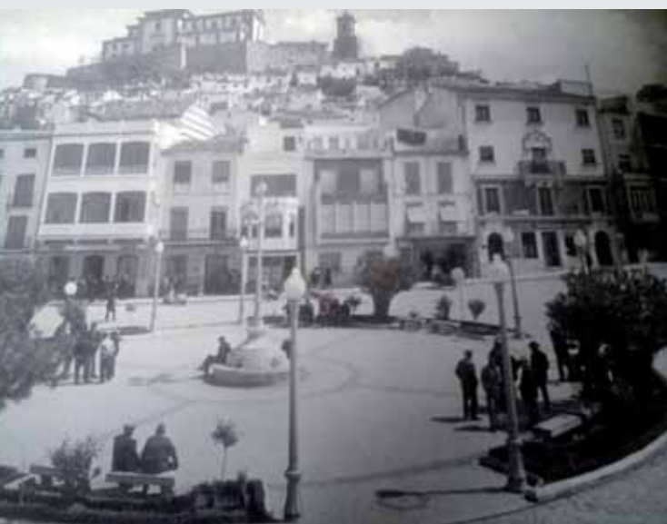
16. Vista de la parte central de la plaza, con la glorieta existente en los años 60.
