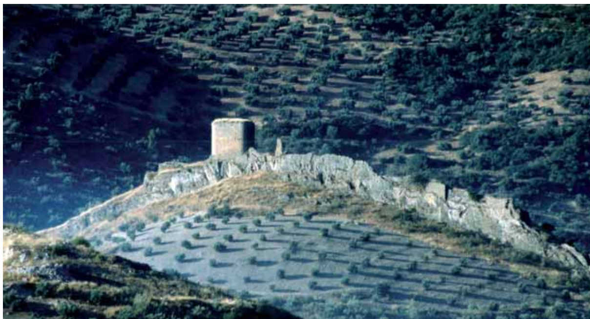
Fortaleza de la Encomienda del Víboras.
