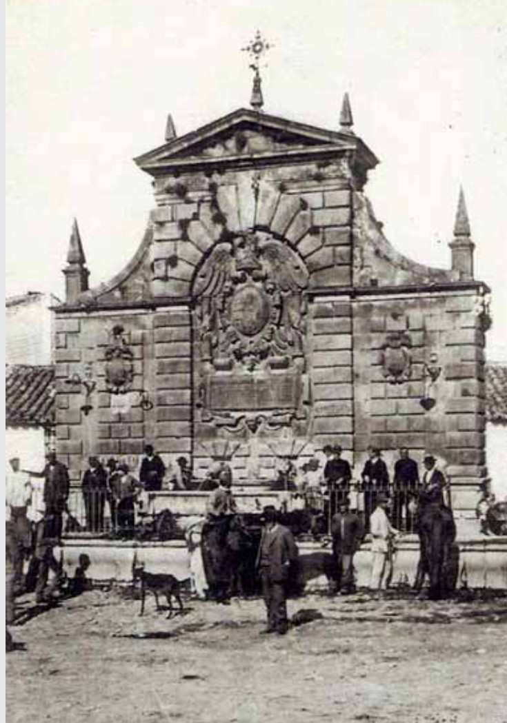
27. El pilar de la Fuente Nueva en su emplazamiento original. Obsérvense las barandillas metálicas que no fueron instaladas tras el primer traslado.
