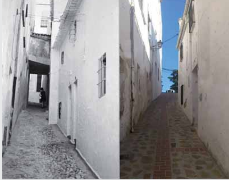
16 - Dos vistas de la calle Camarín, antes y después del derribo del paso elevado tan típico
