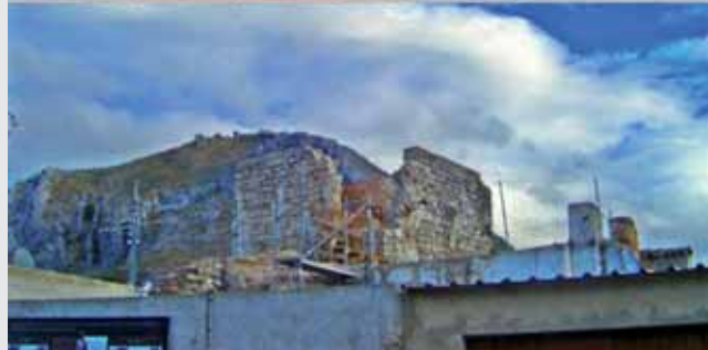
8 - Tres imágenes de la torre Almedina, en las que se muestran diversas etapas de su rehabilitación
