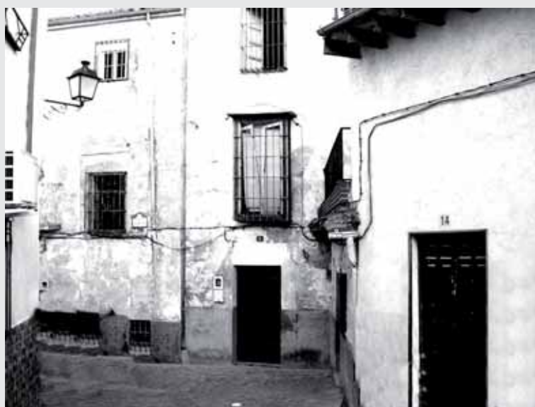
6 - Calle Almedina, que muestra en la actualidad un lamentable estado, consecuencia del abandono
