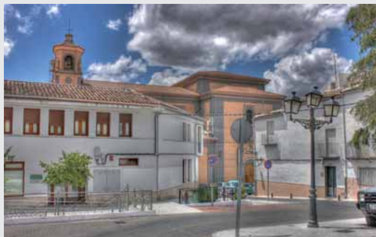
19 - Vista actual de la plaza, una vez derribado el edificio que acogía la Casa de Socorro
