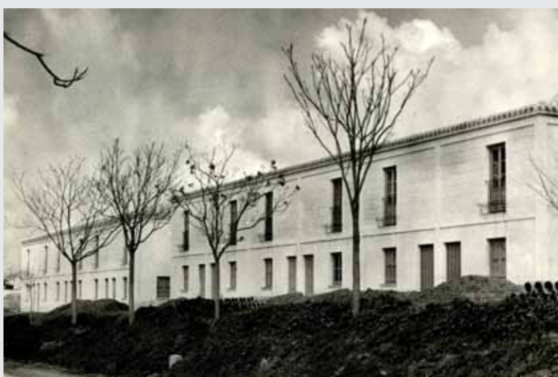
Vistas delanteras de la barriada que da a la actual calle Príncipe Felipe.
