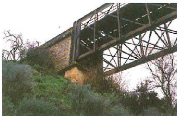
Estribo del viaducto de Belda
