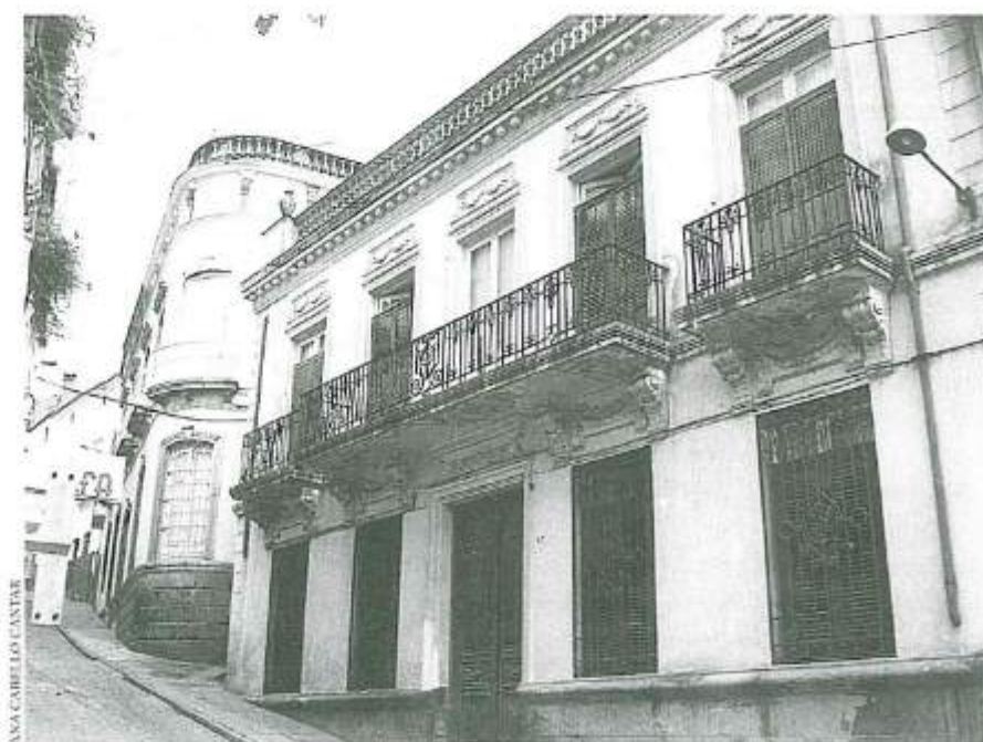
Casa historicista sita en el Albollón, construida en los años 90 del siglo XIX
