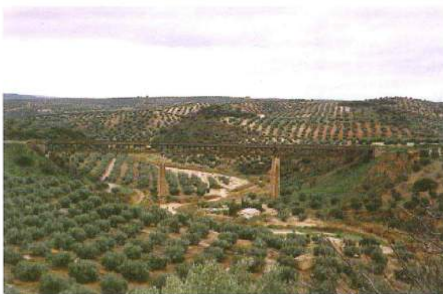
El viaducto de Belda entre meandros del arroyo Salado
