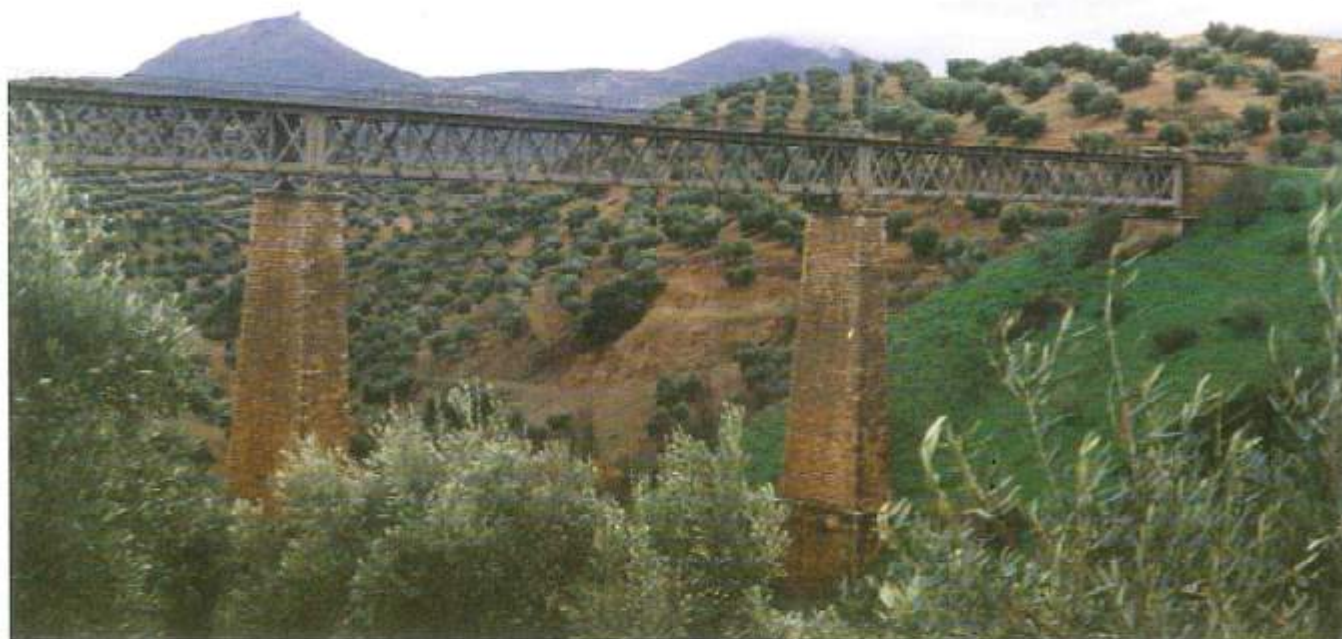
El viaducto de La Sierrezuela en primer término y detrás La Peña
