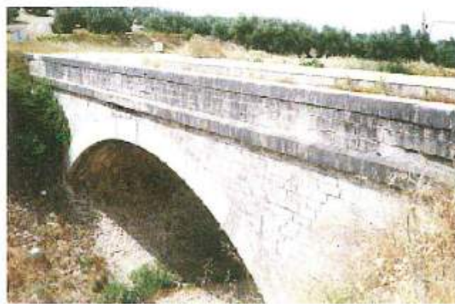
Elegante arco rebajado en el puente de la antigua carretera de Alcaudete
