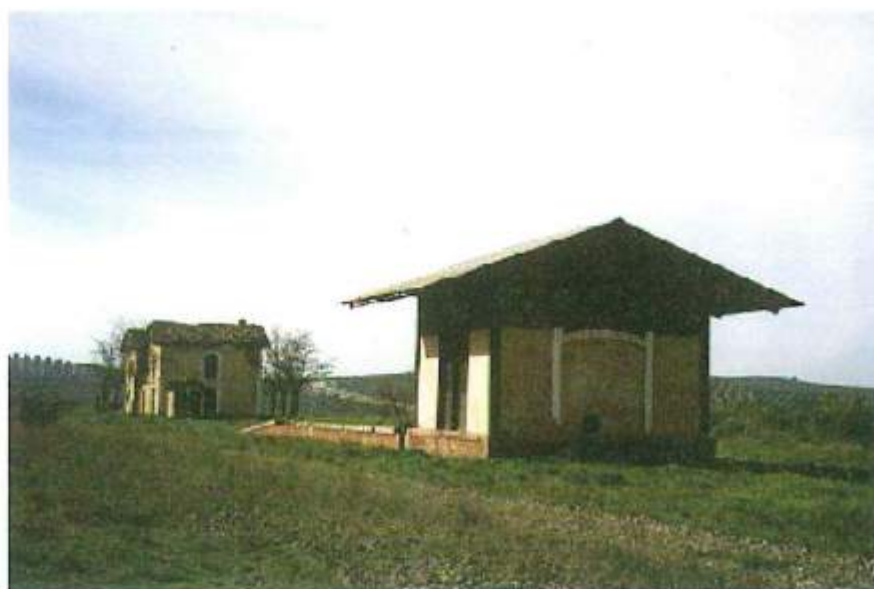
Muelle cubierto de mercancías y andén elevado de la estación de Vado Jaén
