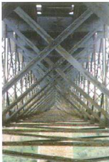
Estructura metálica del viaducto de Belda vista desde uno de sus estribos
