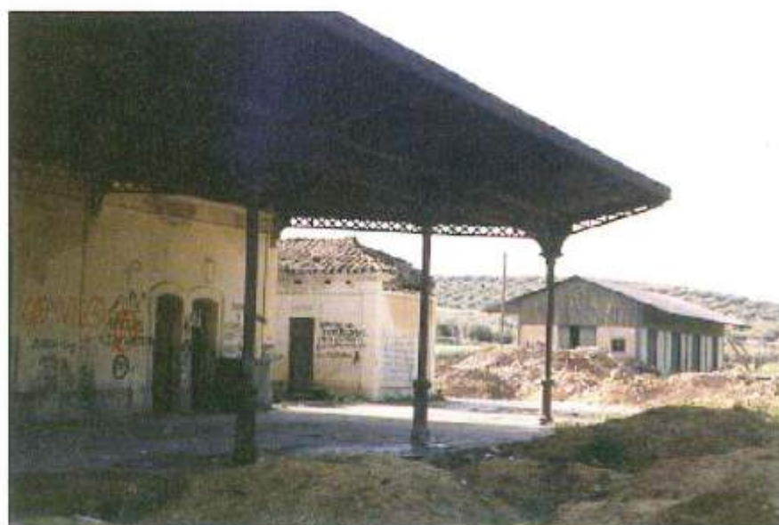
Andén principal y muelle cubierto de la estación de Martos
