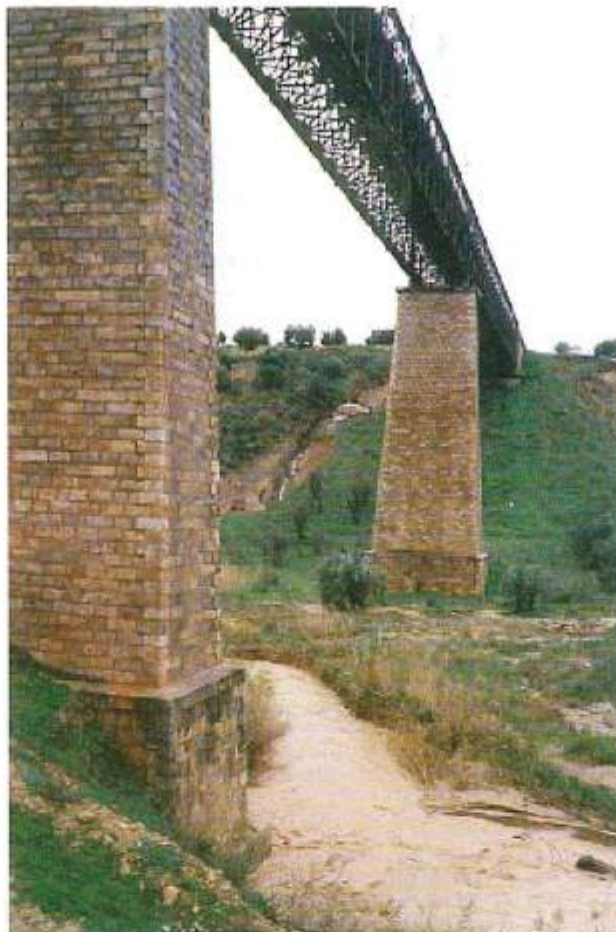
Vista de las pilas del viaducto de Belda
