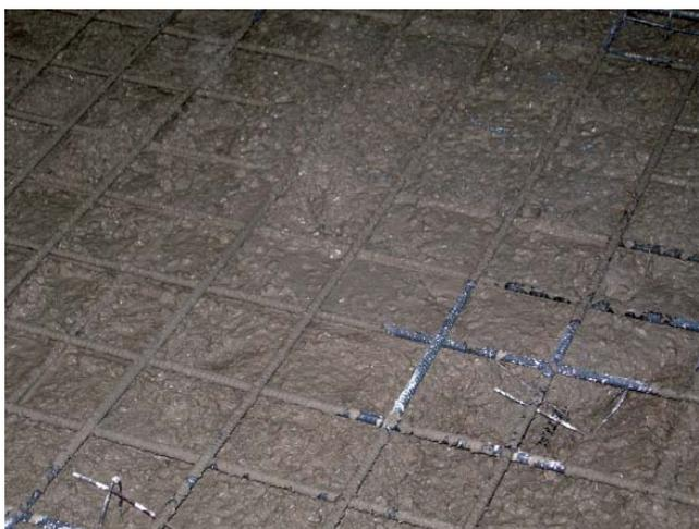
Vertido de hormigón sobre la estructura previa.
