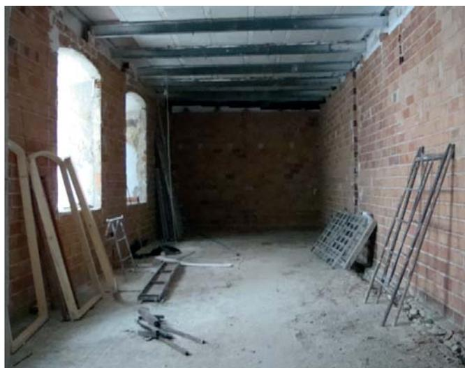
Trasdosados antihumedad ejecutados en la planta semisótano.
