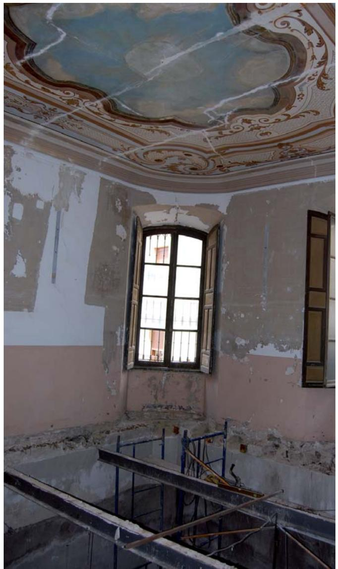
Fotografía en la que se ve el sellado de grietas y falta del suelo en mitad del proceso de restauración.
