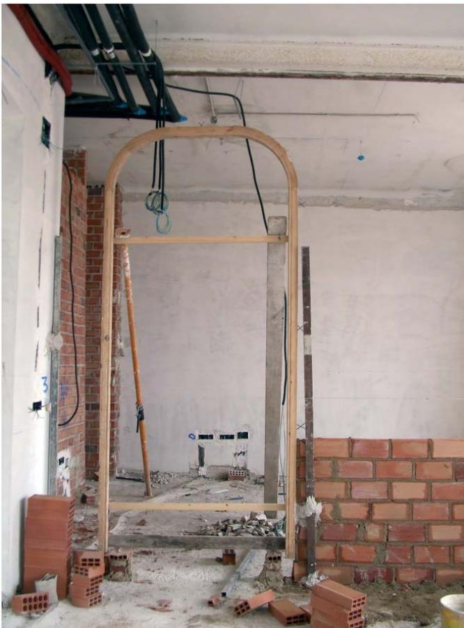
Durante la ejecución de la tabiquería interior con aislamiento acústico y colocando los premarcos para recuperación de la carpintería original.
