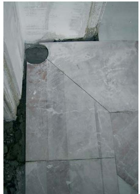
Detalle del corte del mármol para colocación posterior de los bajantes de fundición.
