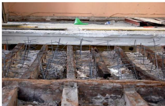
Conectores de ferralla realizados a medida para grapar el mallazo que daría consistencia a la losa de hormigón del nuevo forjado.
