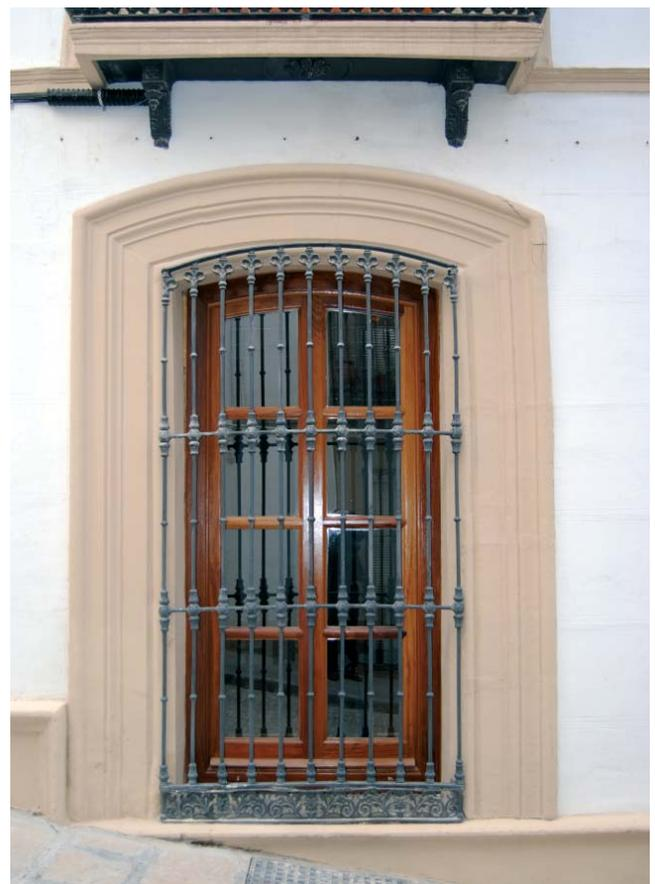
Vista de las carpinterías exteriores colocadas en madera de iroco, a imagen de las originales.
