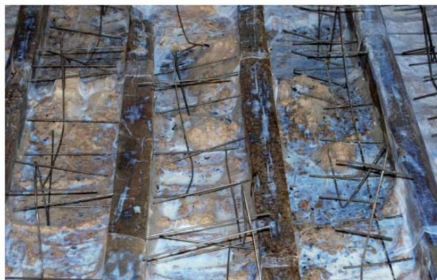
Consolidación del yeso y la madera con resina acrílica y gasa.
