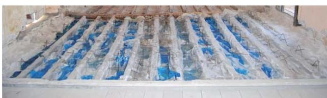
Fijación de los conectores al forjado con resina de poliéster y fibra de vidrio.
