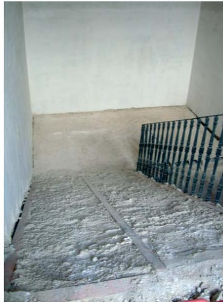
Detalle del estado que presentaban las escuadrías de madera de sujeción de la baranda, agrietadas. Y vista de la escalera, tras la eliminación del peldaño.
