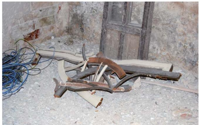
Estado en el que quedó el remate de una de las anteriores puertas por la deficiente manipulación.
