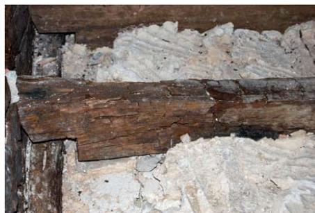
Estado del forjado en su parte superior una vez levantada la solería.
