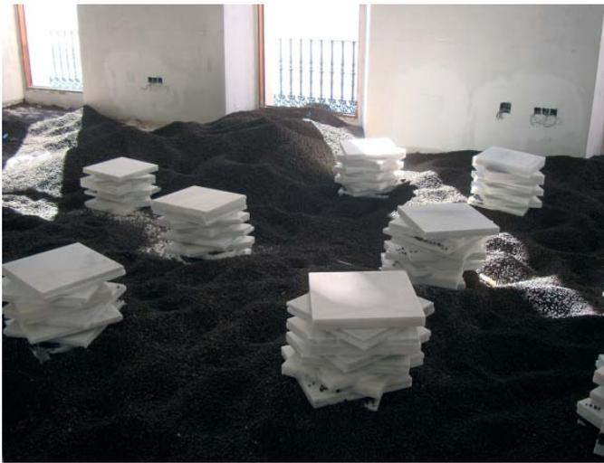
Para aligerar la carga de los forjados se extendió una capa de arlita previa a la colocación de las baldosas de mármol blanco.
