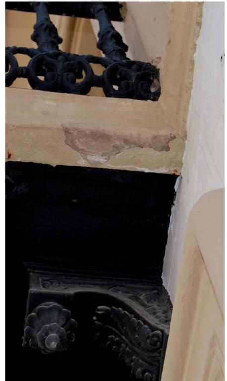
Deterioros causados por la humedad al no usar los productos hidrofugantes.
