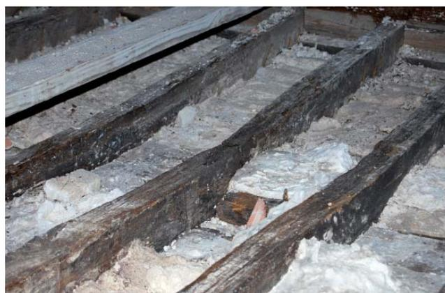
Obsérvese la curvatura de las vigas de madera podrida.
