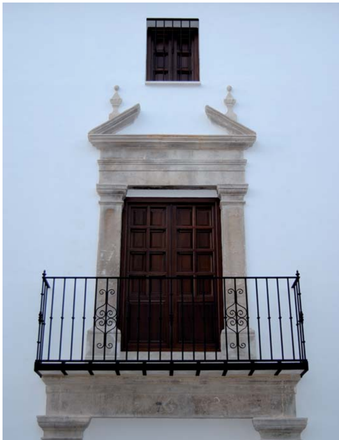
Detalle de la parte alta.
