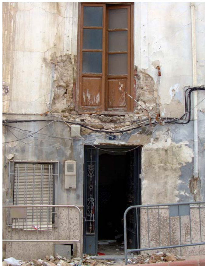
Estado previo de la vivienda sita en la calle Dolores Escobedo, nº 9.
