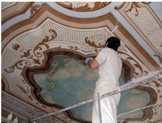
Trabajos de restauración de los cielorrasos.
