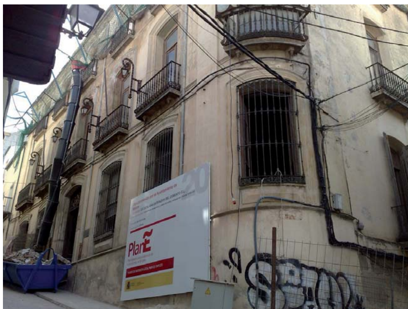
Estado que presentaba la fachada al inicio de las obras.
