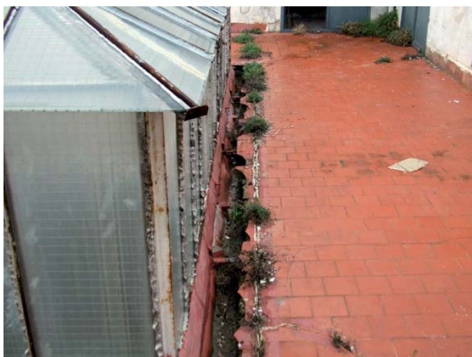
Se puede observar el estado que presentaba la terraza sobre la galería perimetral al patio y el lucernario o claraboya.
