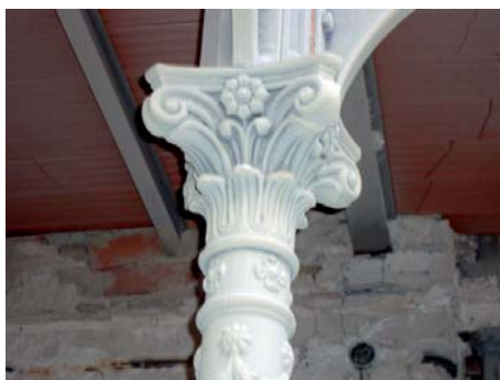
Detalle de uno de los capiteles de los pilares después de su restauración, antes de recibir el tratamiento antioxidante.
