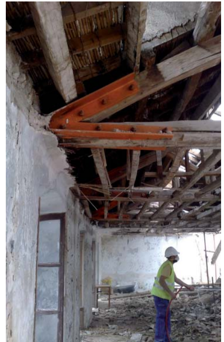
Fotografía tomada desde la cubierta durante la demolición de la misma; obsérvese el mal estado que presentaba el muro de fachada de esquina donde también se puede apreciar el canalón lleno de plantas.
