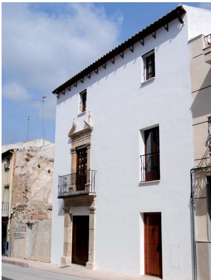
Estado reformado tras la intervención.
