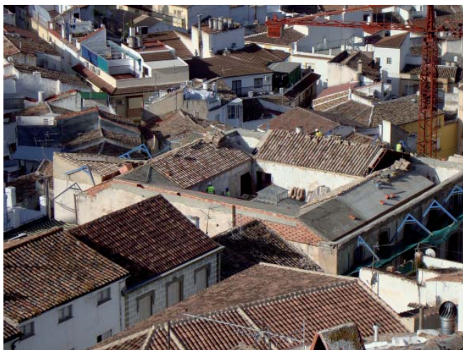
Fotografía aérea de la cubierta del edificio durante su ejecución.
