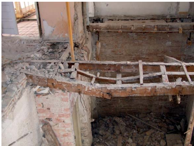
Fotografía tomada en la escalera principal; obsérvese que parte de la cubierta y del falso techo se encontraba derrumbado; en este caso el forjado se componía de vigas de hierro.
