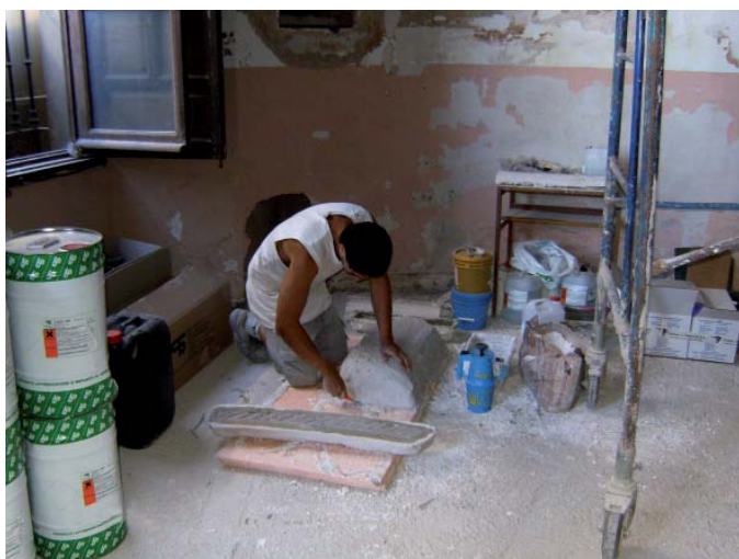
Proceso de reproducción de molduras.
