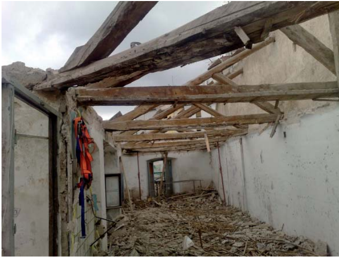
Proceso de demolición de la cubierta.
