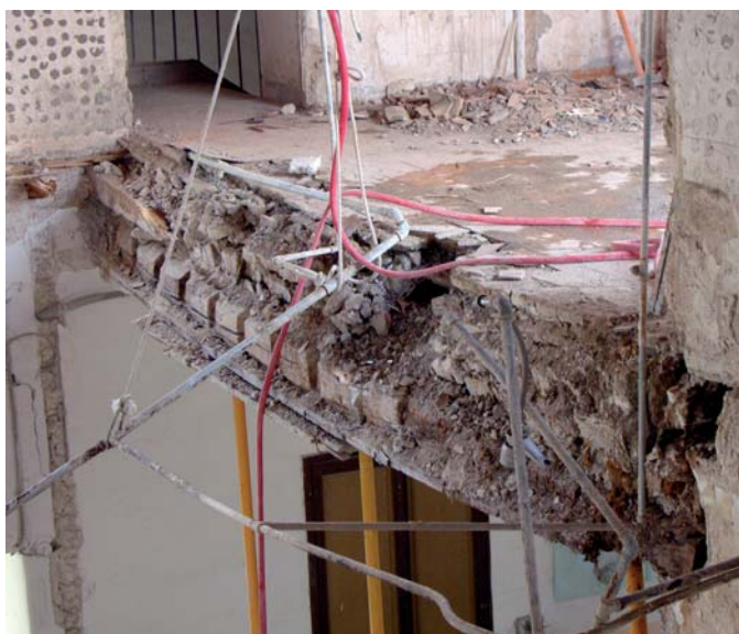
Fases de demolición: obsérvese el grueso del suelo y, por ende, la excesiva carga que actuaba sobre las vigas de madera, capa sobre capa de suelos, como consecuencia de las diferentes reformas realizadas con el paso de los años.
