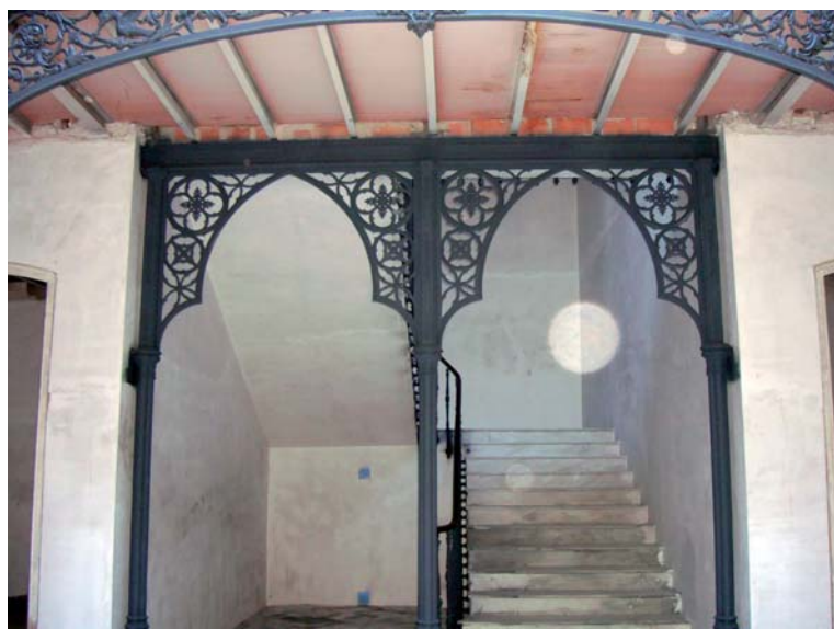
Arquería de hierro fundido de acceso a la escalera después de la restauración, y los muros ya enlucidos a falta de pintura.
