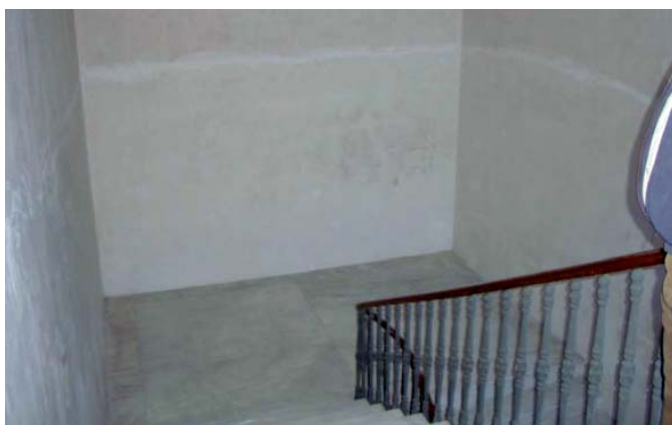
Caja de escalera principal ya restaurada.
