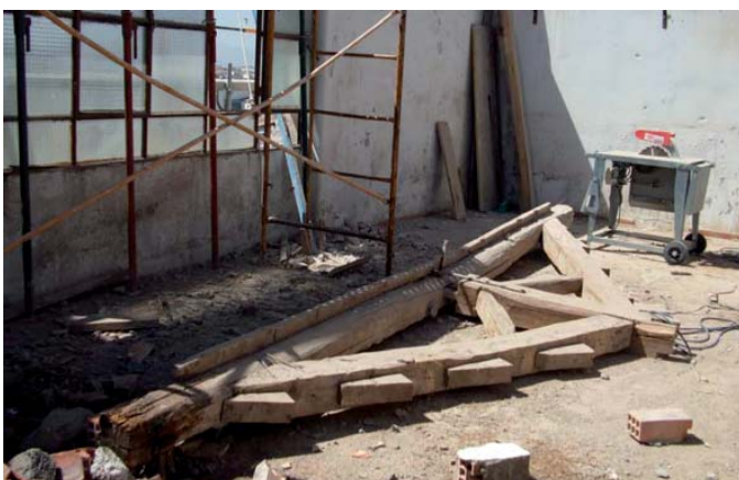
Cercha de madera existente ya desmontada que posteriormente será restaurada.
