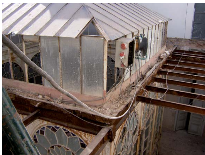
Demolición del forjado de techo de la galería perimetral al patio; nótese el estado en que se encontraba su estructura y el lucernario o claraboya.
