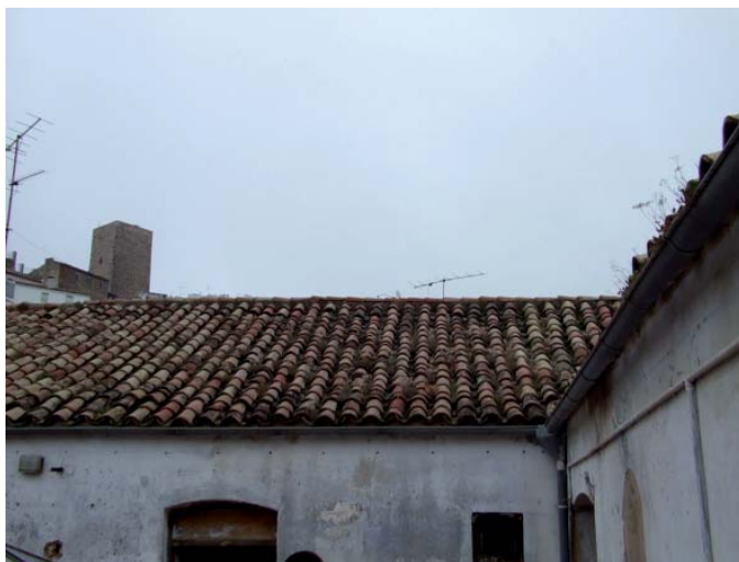
Estado en que se encontraba la cubierta.
