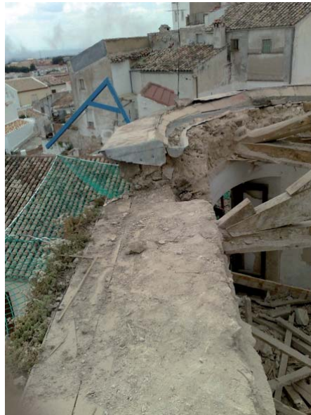
Fotografía tomada desde la cubierta durante la demolición de la misma; obsérvese el mal estado que presentaba el muro de fachada de esquina donde también se puede apreciar el canalón lleno de plantas.
