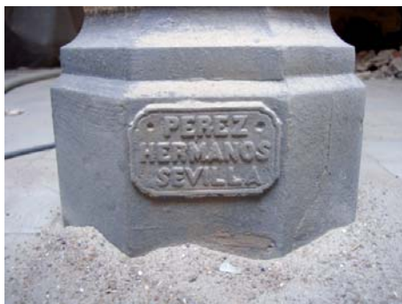
Detalle de la placa que identifica la fundición donde se construyó la cerrajería del patio central; la misma fue descubierta en la base de un pilar después de la restauración, permanecía oculta por las sucesivas capas de pintura.
