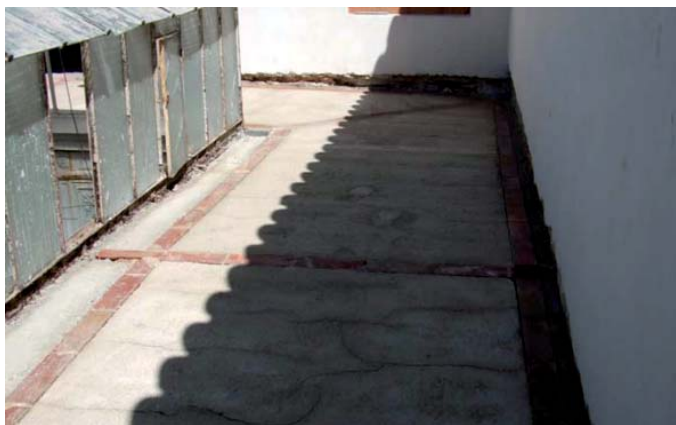
Ejecución de la nueva terraza sobre la galería perimetral al patio.
