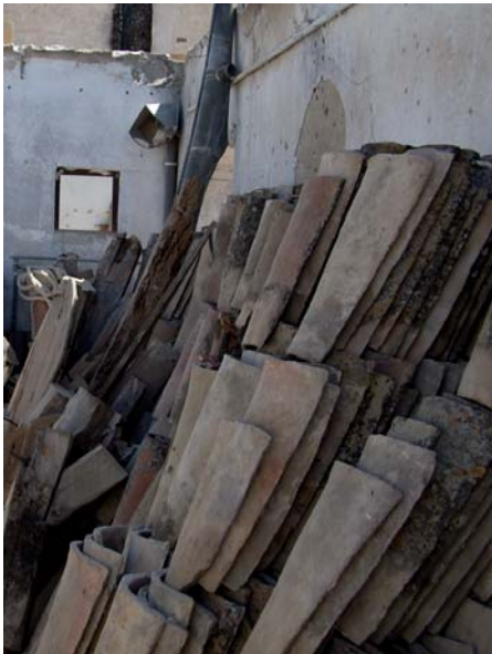
Apilado de las tejas para ser reutilizadas.
