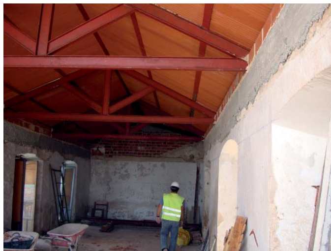
Fotografía tomada en el interior durante la ejecución de la cubierta.
