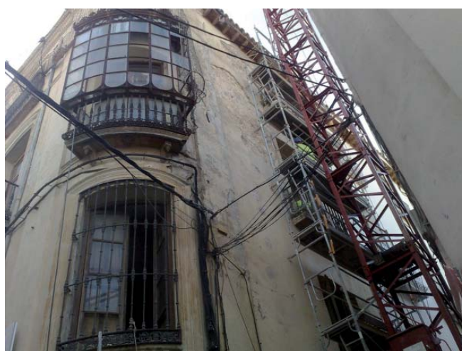
Imágenes de la fachada del edificio antes de su restauración.
