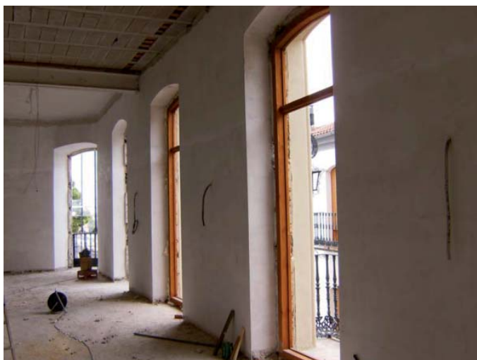
Planta primera durante la ejecución de los revestimientos y la colocación de la carpintería de fachada.
