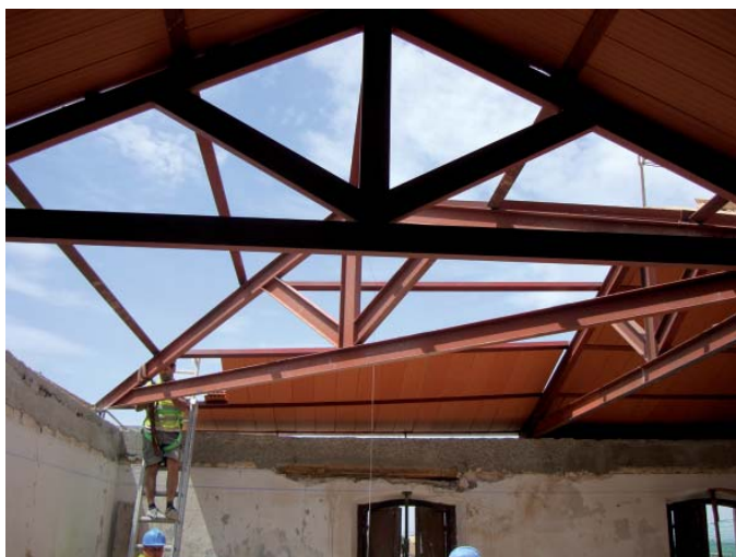
Trabajos de ejecución de la nueva cubierta.
