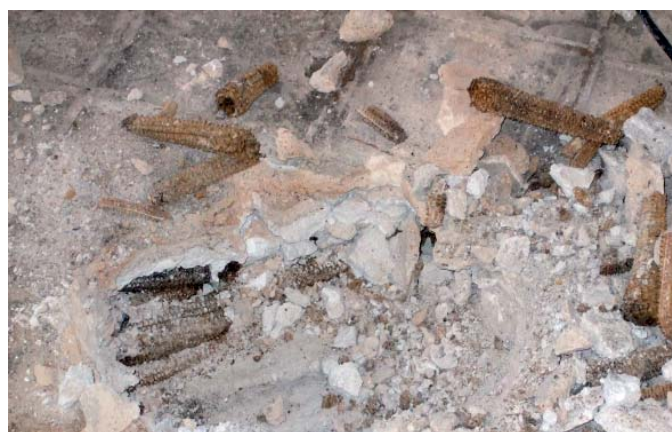
Se puede observar las mazorcas de maíz aparecidas durante la demolición de algunos forjados: estaban utilizadas como relleno de los huecos entre las vigas, solución casera y un buen ejemplo de reciclado, ya que posiblemente en la época el material, una vez extraídos los granos, se desecharía, por lo que sería un material barato, fácil de conseguir por la proximidad de huertas, además de liviano y muy aislante.
