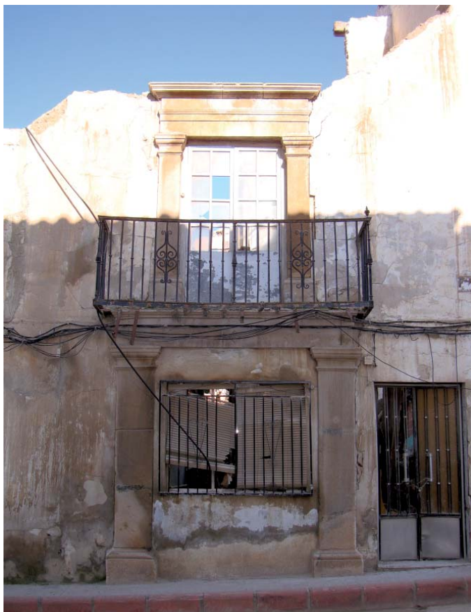
Estado previo de la fachada de la vivienda sita en la calle Dolores Escobedo, nº 7.
