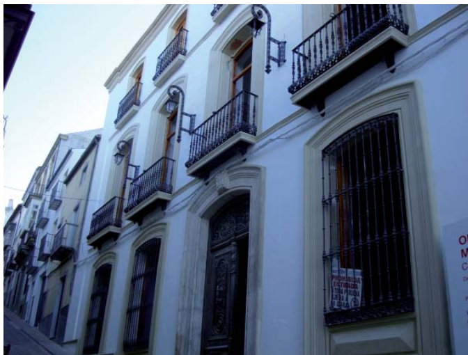
Fachada a calle Dolores Torres ya restaurada.
