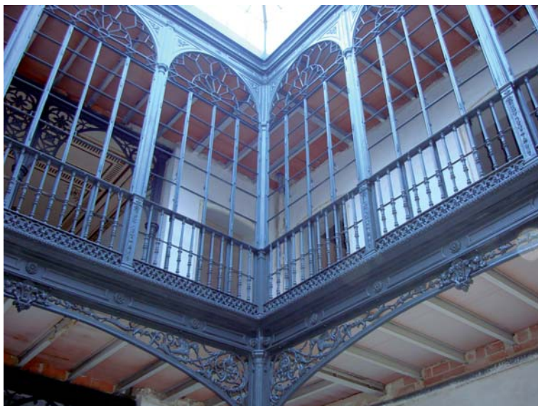
Imagen general del patio una vez restaurado, donde se puede observar los forjados que se han ejecutado en la galería perimetral y su cerramiento metálico después de la intervención; nótese la profusa decoración de la cerrajería, muchas de ellas invisibles con anterioridad, en algunos casos por efecto del óxido y en otros por las sucesivas capas de pintura.
