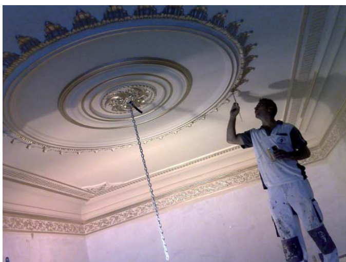
Restauración del falso techo de la escalera principal.
