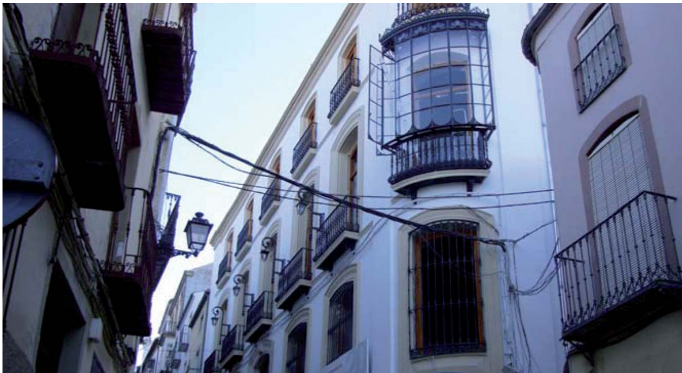
Fachada esquina a calle Bahondillo ya restaurada.
