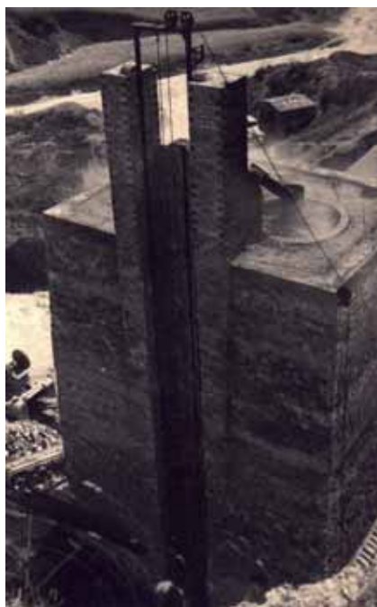
Torre con dos hornos verticales y montacargas de la fábrica de cementos Ríquez en la carretera de Los Villares. Hacia 1960.
