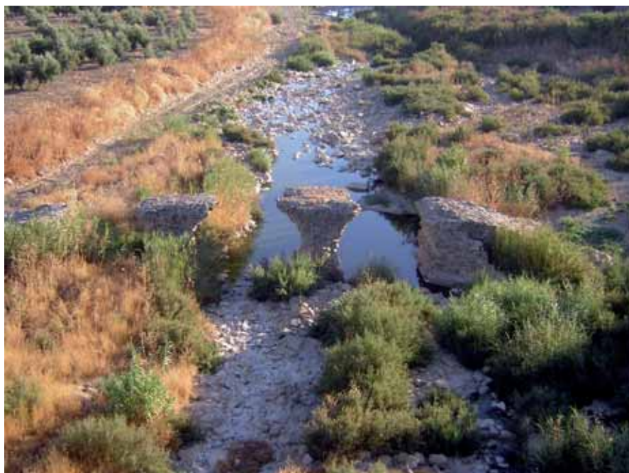
Hormigón en la pila y estribos del puente romano de Porcuna. Probablemente de época republicana (Siglo I a.C).
