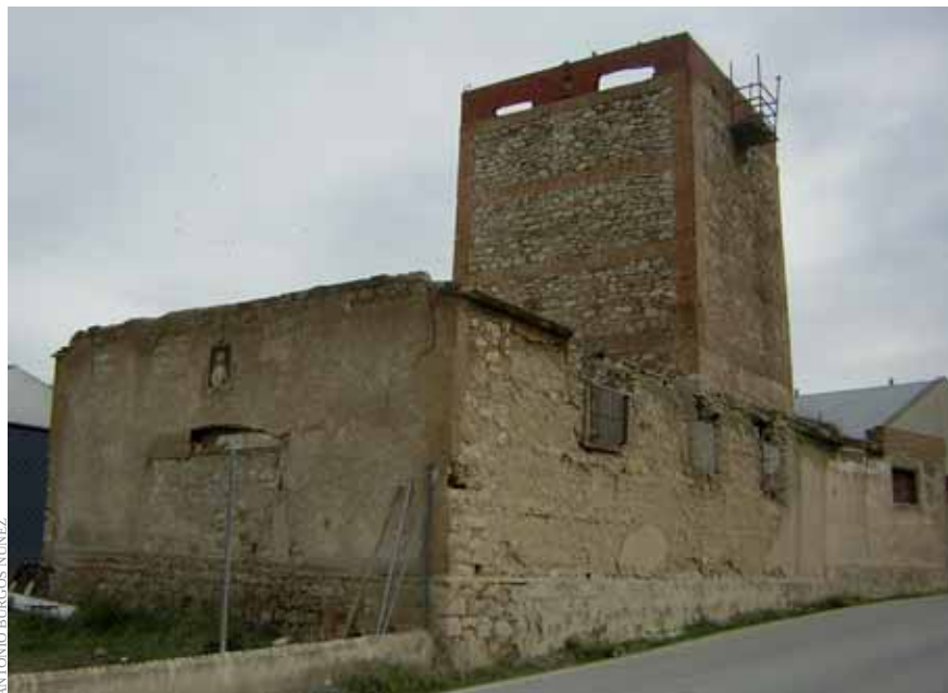
Fábrica de Sáez de Tejada antes de la rehabilitación. Nave con muros de tapiales y torre de hornos con dos hogares.
