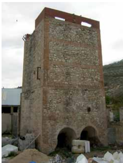
Fábrica de Sáez de Tejada antes de la rehabilitación. Nave con muros de tapiales y torre de hornos con dos hogares.
