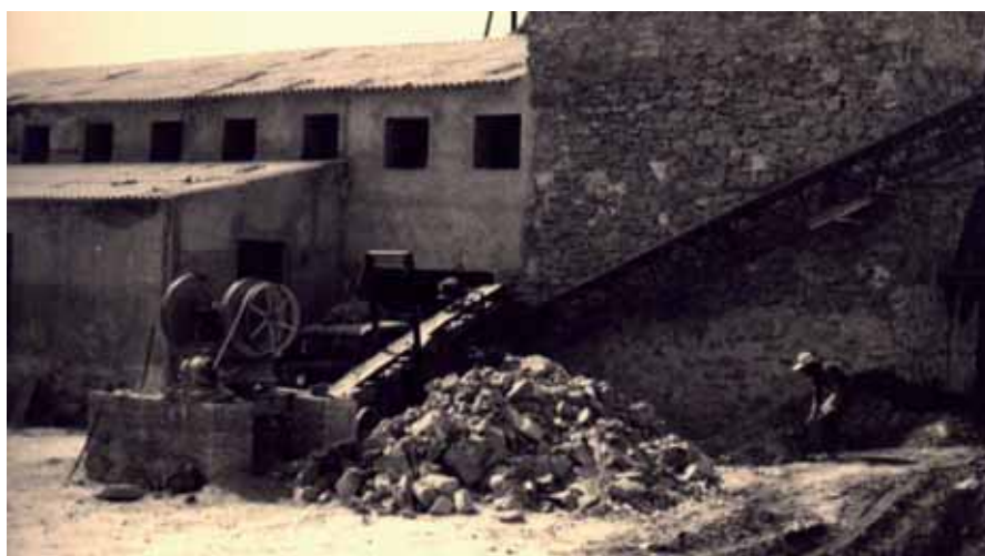
Acopio de piedras, molino de trituración y tolvas de alimentación del horno. Fábrica de Cementos Ríquez de la carretera de Los Villares. Martos, hacia 1960.
