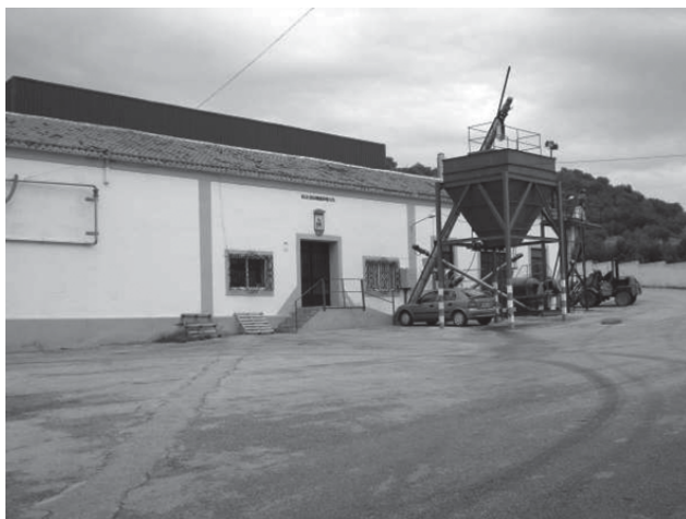
Vista panorámica de la Almazara.
