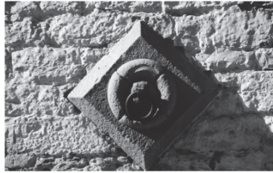
CÁNDIDO VILLAR CASTRO
