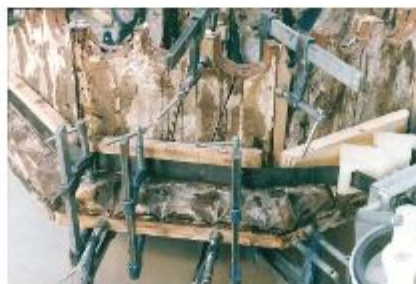
Detalle de la restauración de uno de los elementos integrantes del artesanado de San Esteban.
