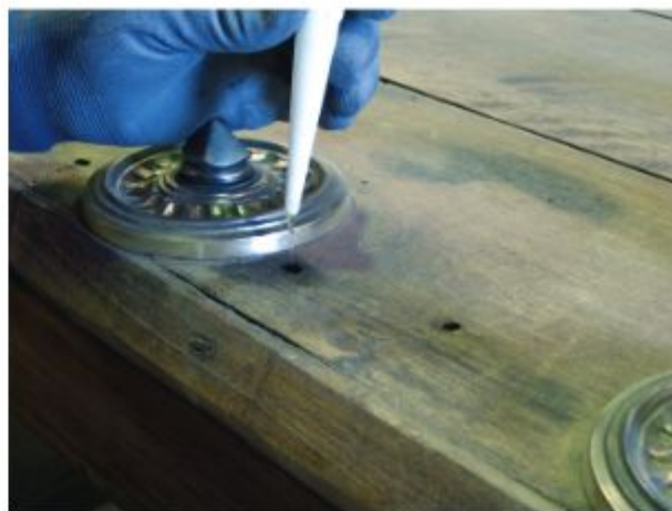
Tras una limpieza a fondo, se procedió a la desinfección y consolidación de las partes afectadas.
