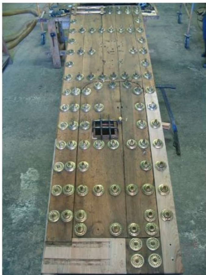
Al igual que a la otra hoja, a esta se le han colocado partes de nuevo nogal debido al pésimo estado del original.
