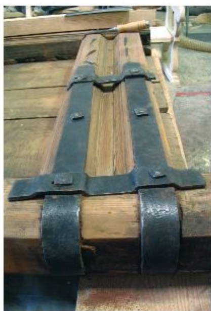
Detalle de las abrazaderas que sujetan los gozmes.
