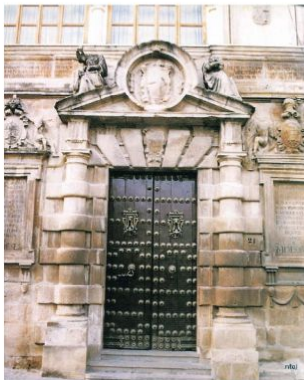
Fachada del histórico edificio del Ayuntamiento mariteño cuya puerta ha sido restaurada.
