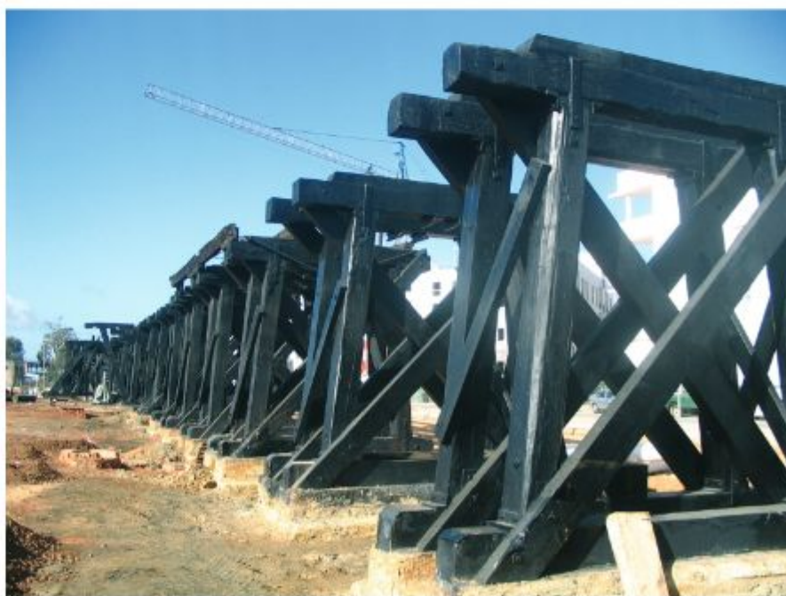
Terminada la primera fase de la restauración.
