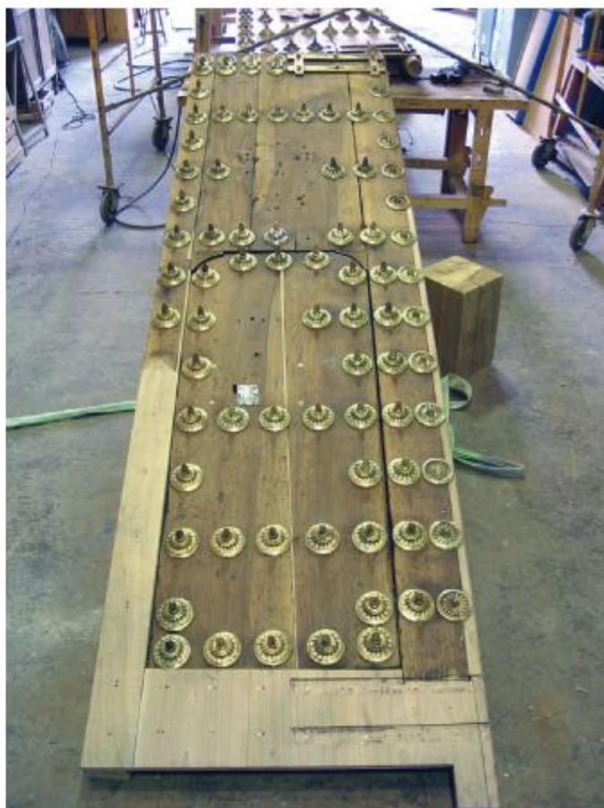
La hoja izquierda ya decapada y con la parte insalvable del revestimiento de nogal repuesto nuevo.
