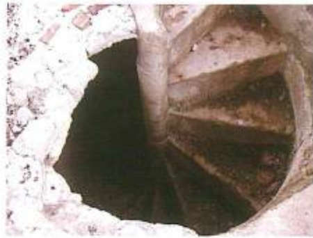
Huoco de escalera, visto desde el suelo del Campanario.
