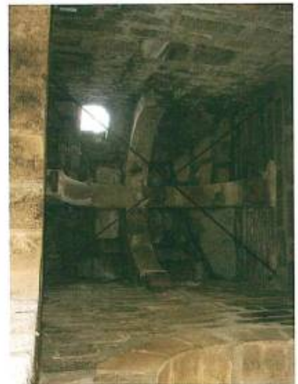
Cubierta del Campanario reforzada por arcos que se entrecruzan.
