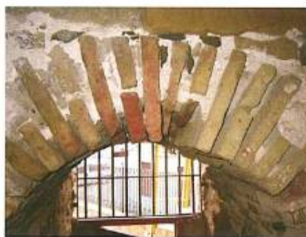
Arco de entrada a la torre defensiva.
