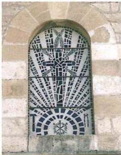
Vidriera en la fachada de San Amador y, arriba, el campanario del mismo templo.
