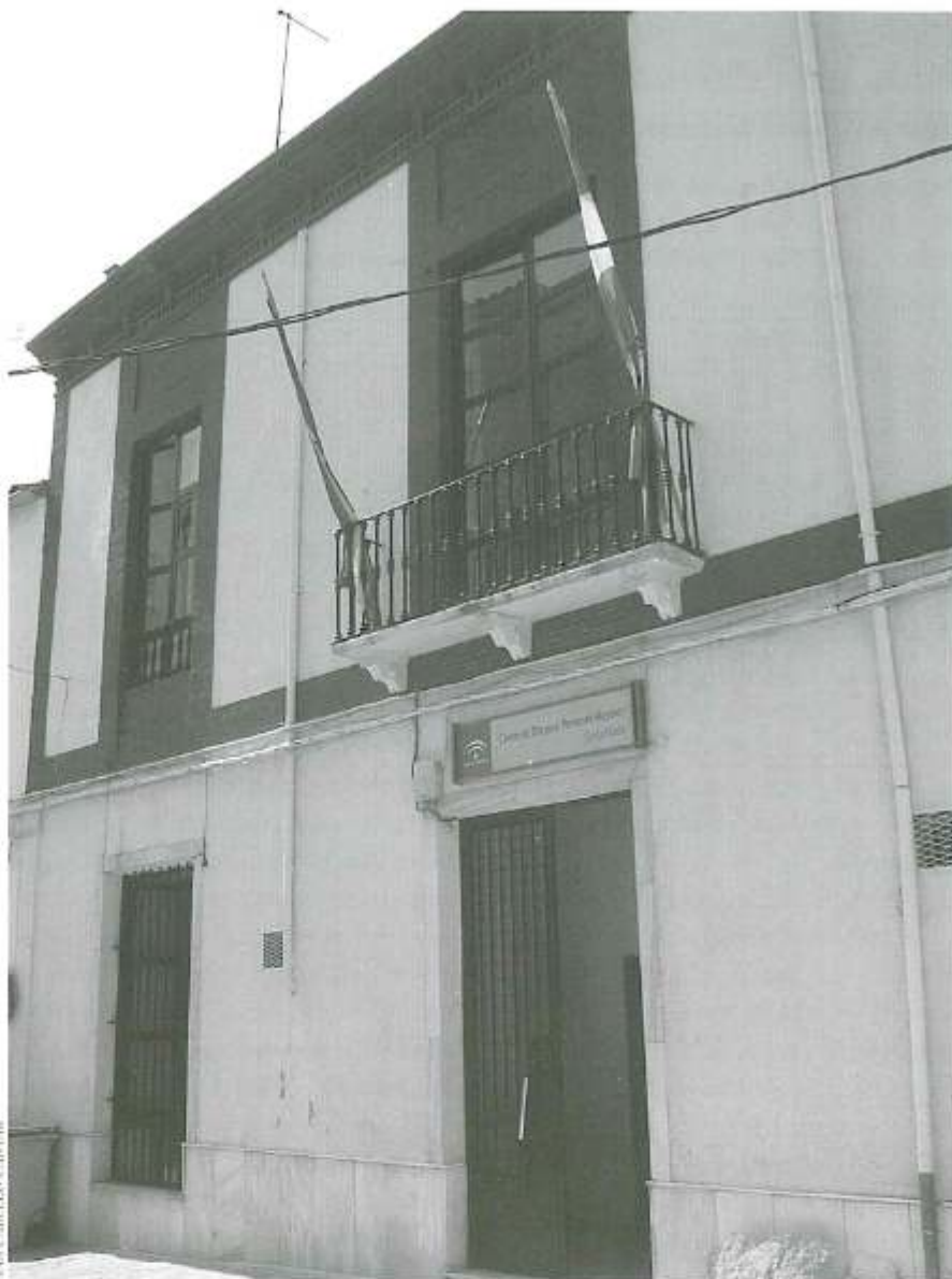
Fachada del antiguo Pósito. Calle Franquera.
