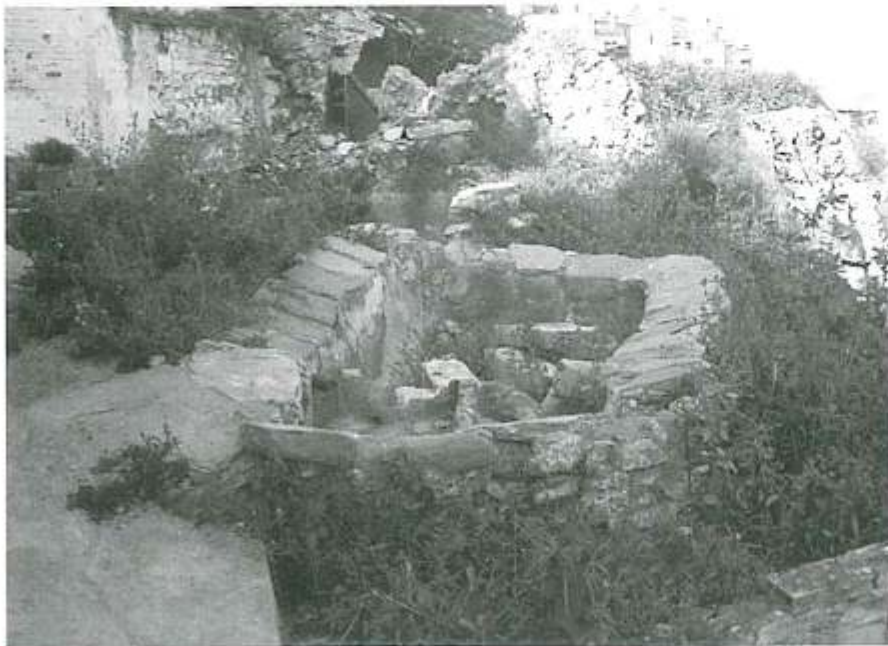
Estado actual del lavadero del Chorro.
