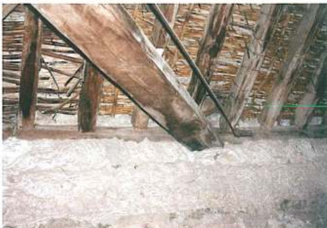
Vista de un cuadril de la armadura de madera del presbiterio; se observa que lo acompaña un tirante metálico de una reparación anterior.
