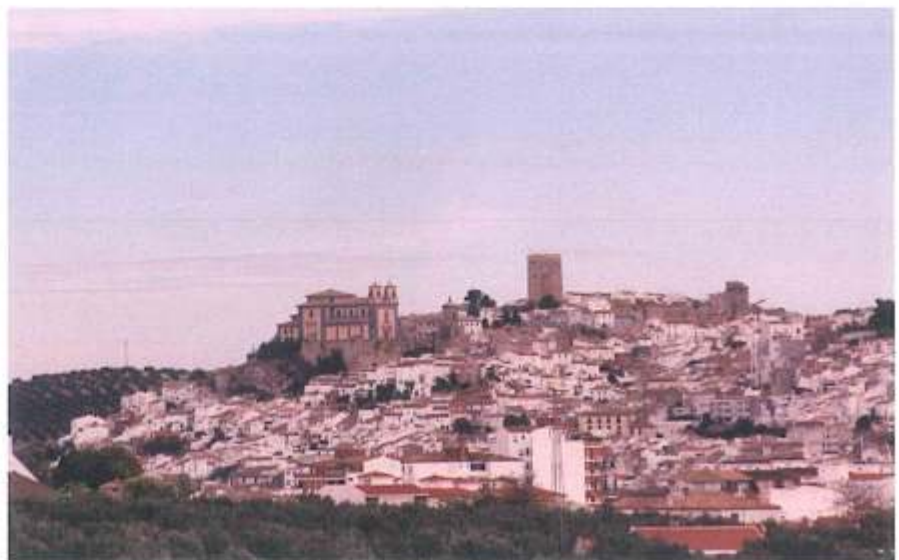
Entre el caserío, en íntima conexión, destacan elementos singulares de la arquitectura religiosa, defensiva... que evidencian el pasado del tiempo.
