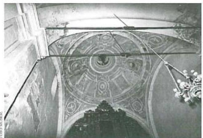
Fig. 8: Visión parcial del coronamiento del retablo barroco, y aspecto global de la cúpula, con los contrafuertes de hierro para apuntalar el arco toral y bóveda.<sup>9</sup>
