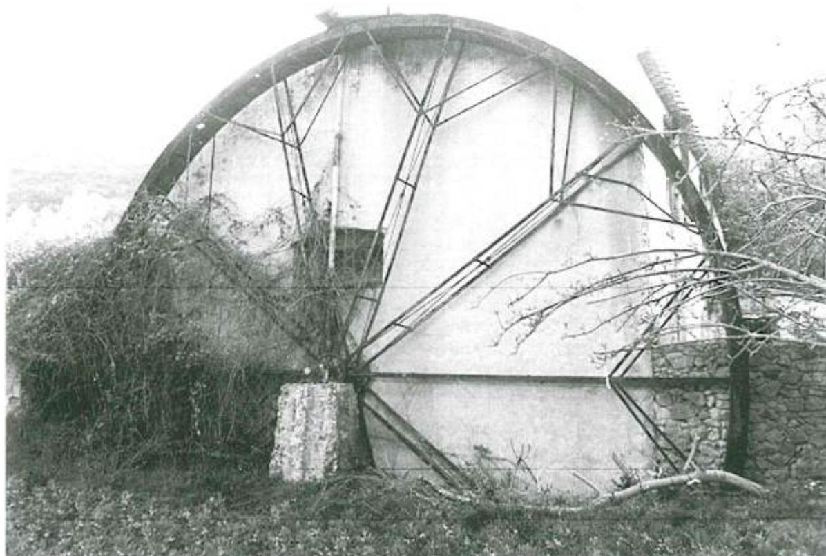
Foto 3: Rueda hidráulica, de 12 m. de diámetro y 80 cangilones.
