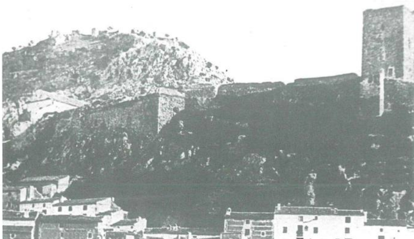
(Fig.4) Bastión de la parte septentrional de la Almedina con su Torre Homenaje, edificios contiguos y el basamento del Castillo con la gran fortaleza de la Peña al fondo.
