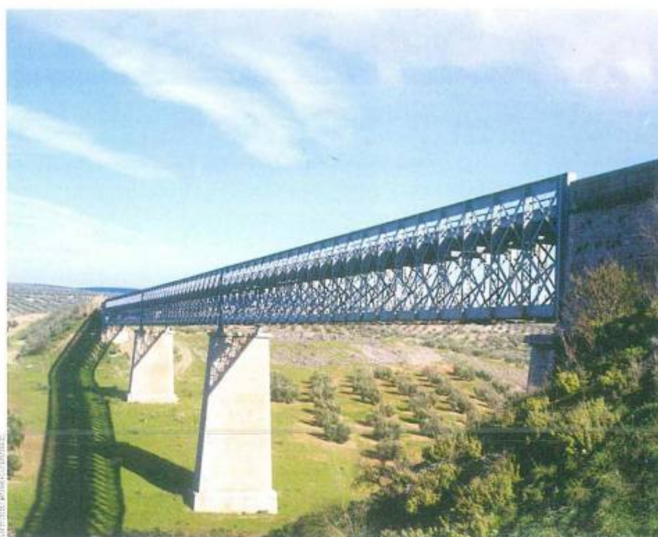
Aún hoy nos asombra la audacia y, como una paradoja, la fiabilidad de esta construcción.
