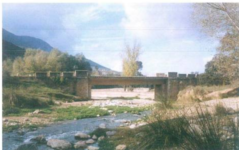
Con el entorno casi seco del cauce del río, el puente nos da una imagen que será recuerdo próximamente.
