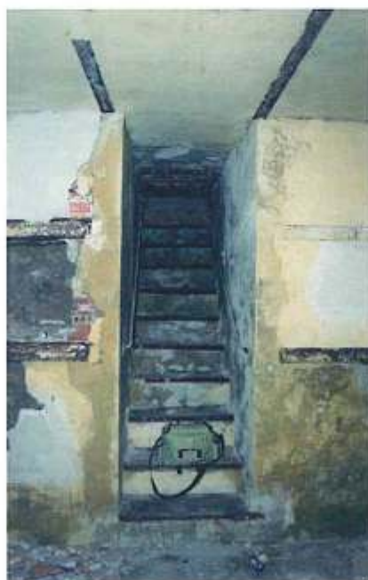
Acceso a la cripta subterránea, actualmente cegado.
