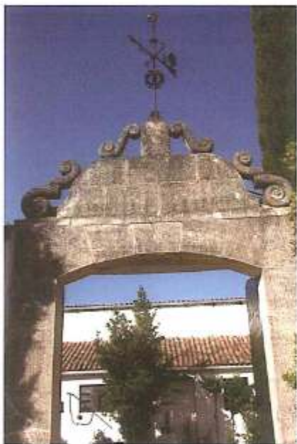
Portón de entrada a uno de los patios, con portada de sillería.
