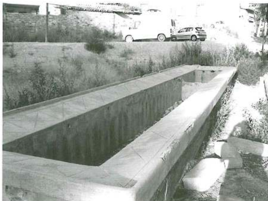
Lavaderos públicos del barrio de Magraners.
