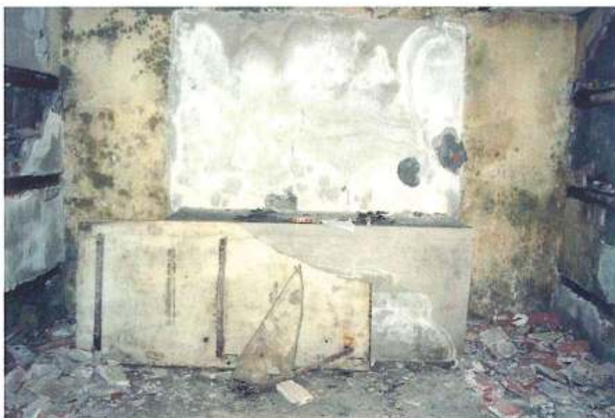
Cripta bajo presbiterio. Apoyada sobre el altar la antigua lápida que cerraba el acceso al panteón. A izquierda y derecha nichos de enterramiento. La construcción y todos los materiales de la cripta datan de los años cuarenta. La estructura del forjado del altar mayor es de viguetas metálicas que, por el alto grado de humedad existente, se encuentran completamente oxidadas y corroídas.
