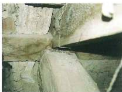
Nudo de apoyo de la armadura de cubierta. La abundante humedad que se acumula en contacto con los muros produce la aparición de hongos y probablemente la pudrición de las cabezas de los pares de madera.
