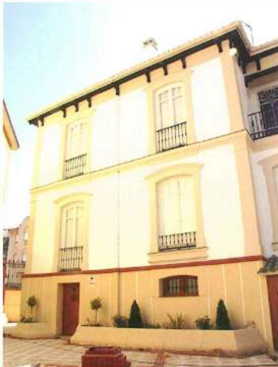
Otro acierto más en la restauración de este inmueble ha sido la elección de los colores de la fachada (cornisa, recercados, carpintería, rejería...)
