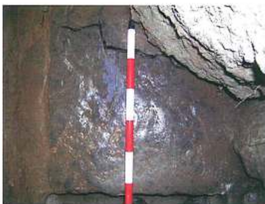
Losa romana de basalto en la plaza de la Constitución, sobre la que se apoya el muro de la capilla. Se observa el corte limpio, sin erosiones en los bordes del corte, provocado por la presión que ejerce el muro de la capilla sobre la losa romana.
