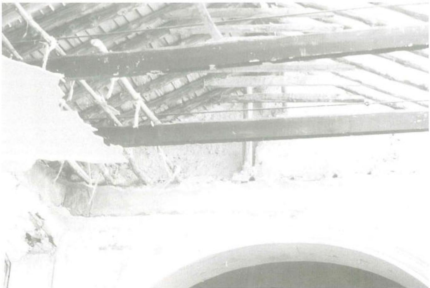
una bóveda que la ocultara; o bien una estructura de vigas de madera y entrevigado también de madera vistosos; o, por último, y ésta fue la opción que finalmente se tomó, reproducir la estructura que existía en el momento de la demolición (pares de vigas formando la inclinación de la cubier-
