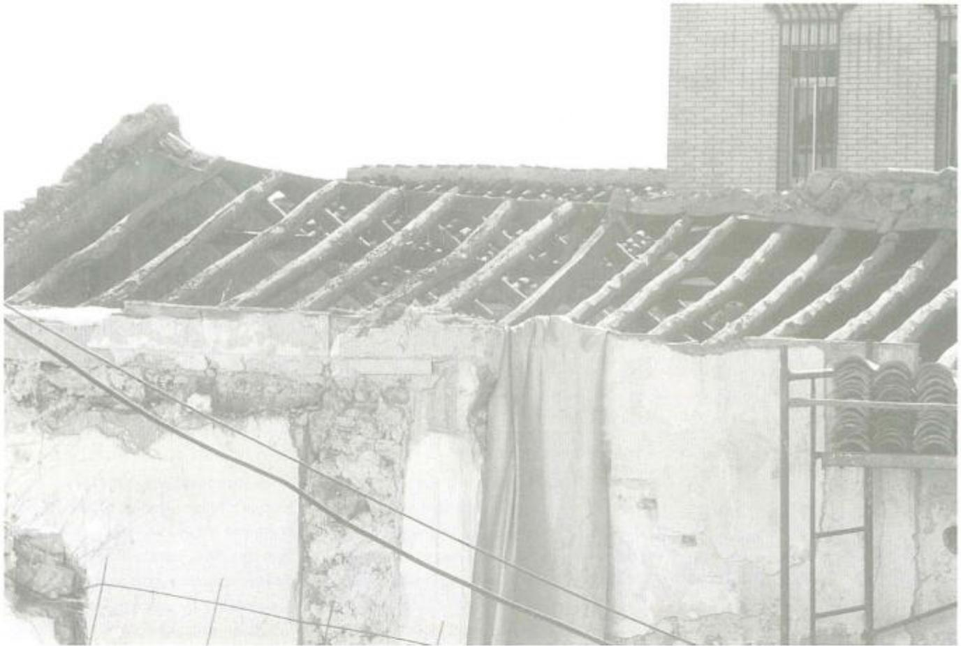
tografías que acompañan al texto y que fueron tomadas durante la demolición. Apoyado en esas vigas de madera se disponía un tablero, también de madera, y la teja árabe. Existían un total de unos 35 pares de vigas de este tipo. Se ha observado durante los trabajos de demolición que, en restauraciones anteriores, se había susti-
