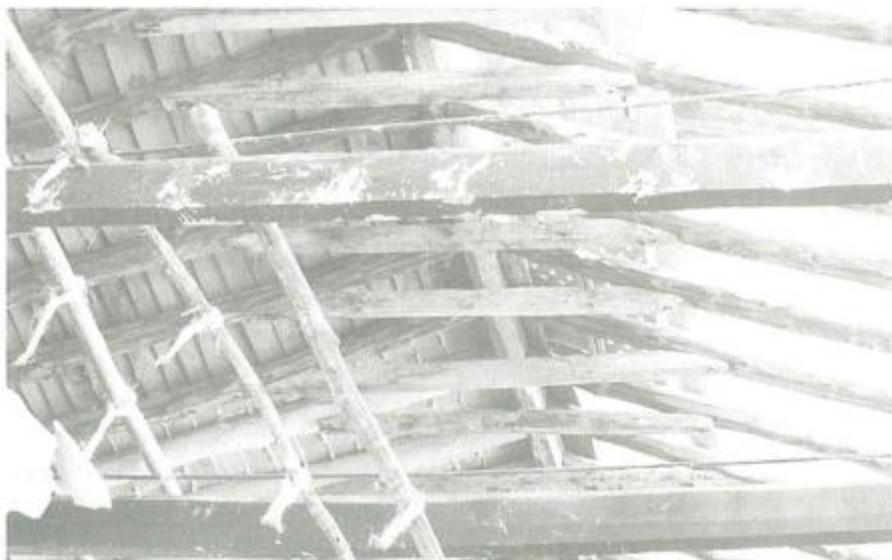
Por debajo de esta estructura de madera, y ocultándola, existía un cielo raso de escayola que creemos fue ejecutado muy recientemente. Curiosamente, por encima de este cielo raso de escayola aparecieron restos de otro cielo raso adintelado que, en una primera inspección realizada en la cata practicada antes de la demolición, se pensó que pudiera ser el arranque de una bóveda de cañón. Tras la demolición se ha podido comprobar que ésta era una hipótesis incorrecta.
