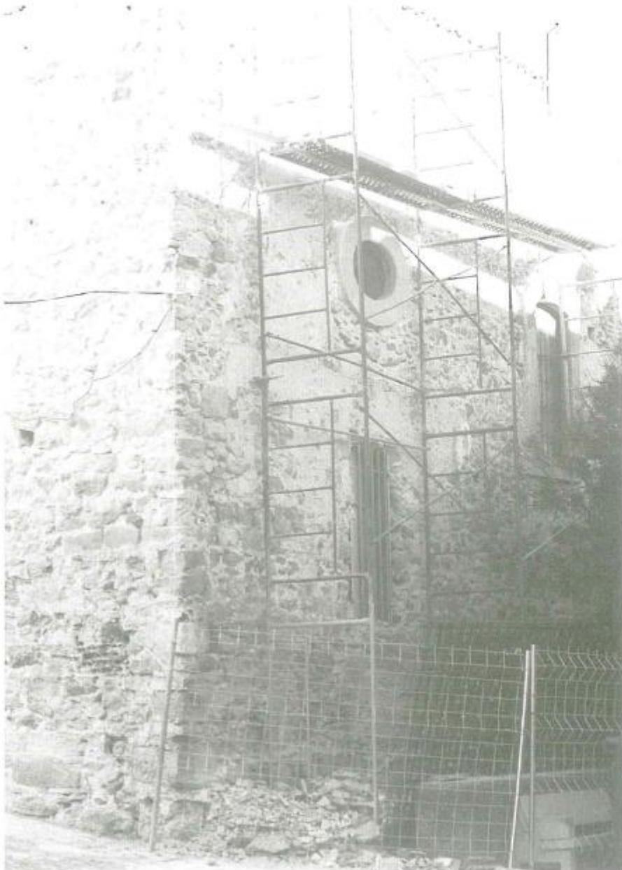
empujes de la cubierta. Además se detectaban importantes desprendimientos de los revestimientos provocados por las fuertes humedades provenientes del terreno. Ante estos síntomas se consideró necesario picar completamente los muros, quitándoles todo el revestimiento para llegar hasta la piedra, así como corregir el desplome en la medida de lo posible.
