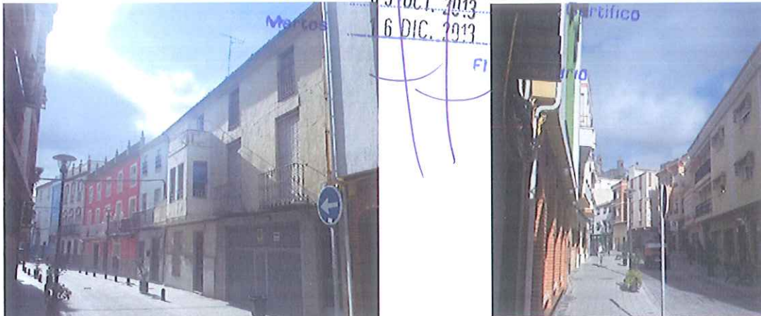
Dos vistas de la calle Carrera, donde se aprecia la renovación edilicia de algunos tramos
