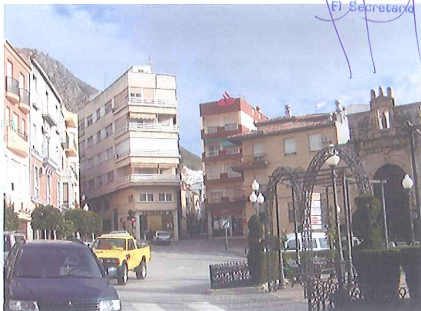
Las dos edificaciones en chafalán, de seis y cinco plantas de altura respectivamente, sobre las que se entiende necesario tomar medidas correctoras.
