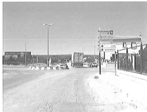
Enlace calle Linares con la salida hacia Alcaudete
