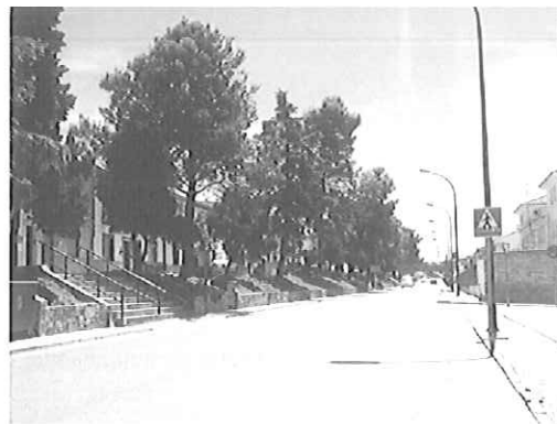
Av. Príncipe Felipe. Desdoblamiento con vía de servicio a las viviendas.
