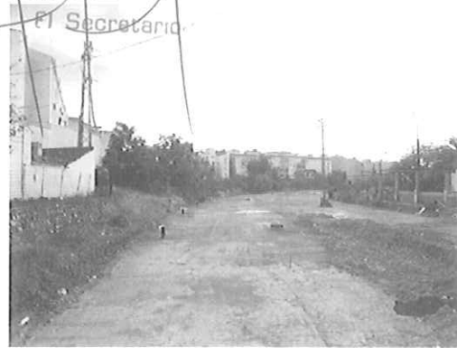
Urbanización en UE-21 en ejecución. Vía verde
