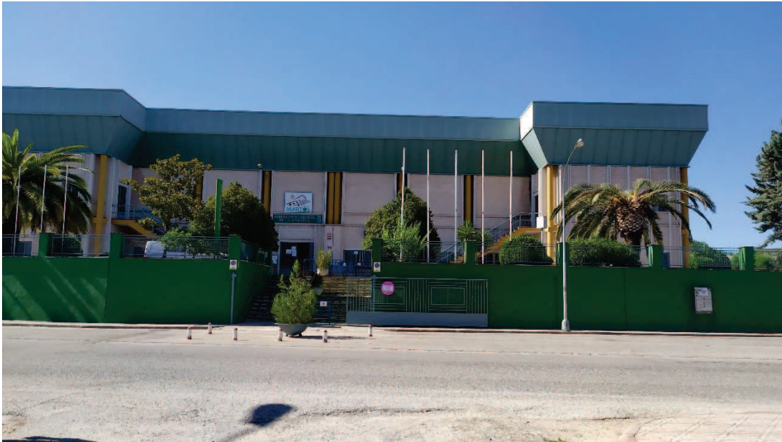
Figura 21. Vista del Polideportivo Municipal de Martos desde el límite sur del sector SU-NC_R4
